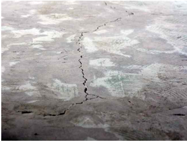
[그림 5.h]바닥완충재의 성능 저하로 인한 바닥 구조 균열 및 완충재 손상 사례
