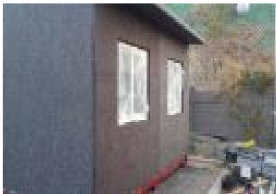
⑧ 마감재 시공 완료
