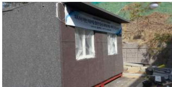
⑦ 외단열 시공완료
