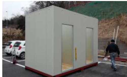
④ 문틀 설치
