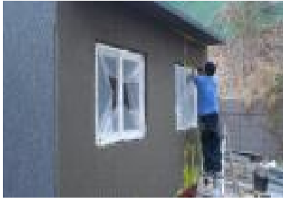
④ 몰탈 시공
