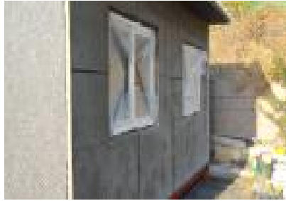
⑤ 몰탈 시공 완료
