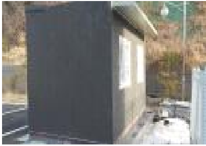
① 시공 전
