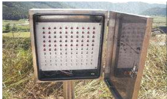
(b) 터미널 보드 설치
