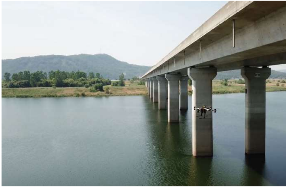
[그림 52] 드론 활용 고속도로 교량 점검(한국도로공사)
