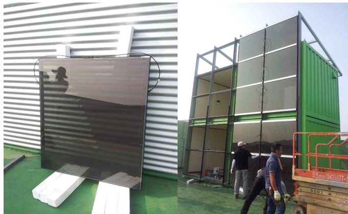
태양광 모듈 설치공사
