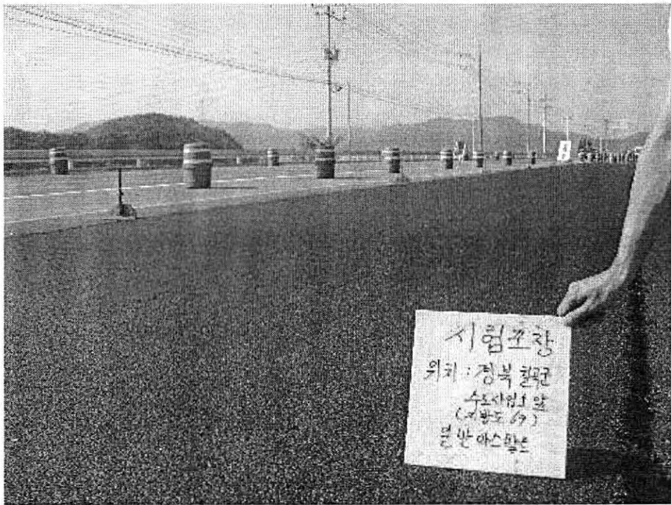
그림 3.50. 경북 칠곡군 일반아스팔트 혼합물 시험포설
