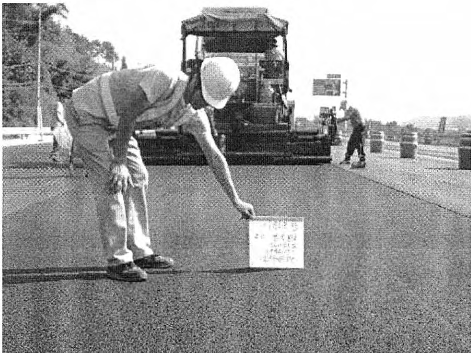
그림 3.51. 경북 칠곡군 L4E10 혼합물 시험포설
