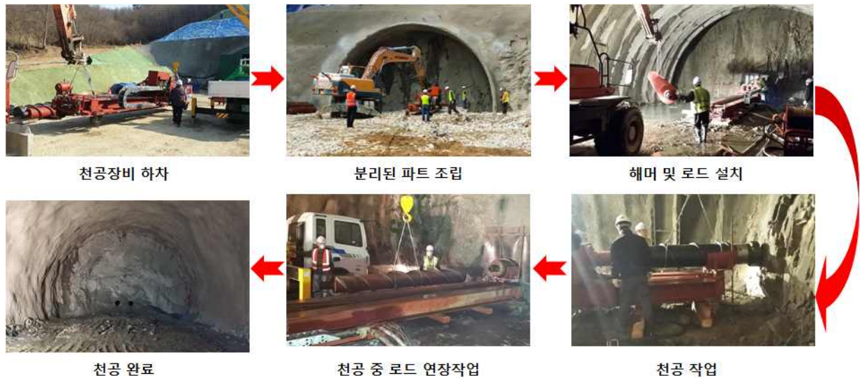
<기존 선대구경 천공장비 설치 과정>
