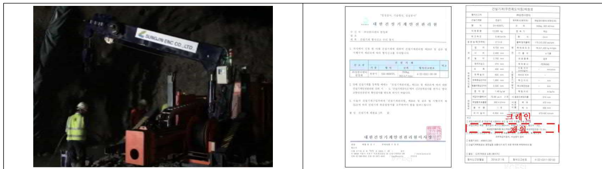
터널 내 크레인 현장 적용(제물포 터널) 및 형식신고서(크레인용량 5ton)
