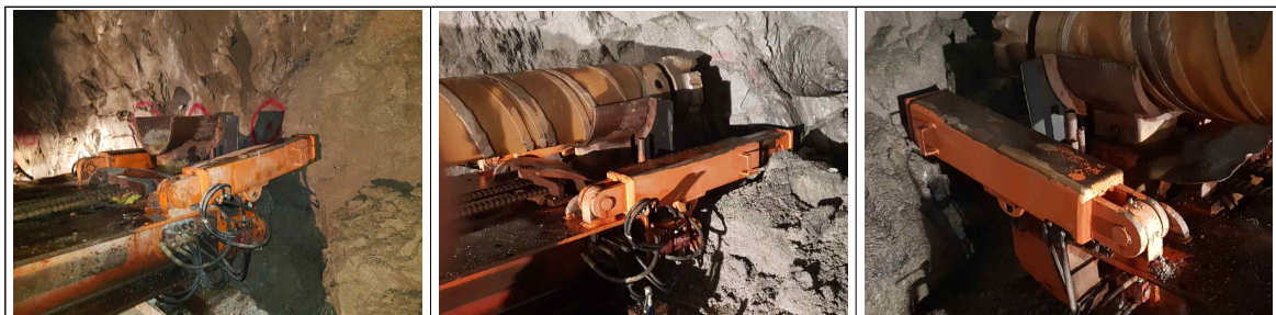
전방 고정 장치 설치
