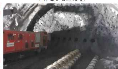
(라) 선대구경 수평천공 작업
