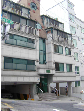
(a) 우리나라 저층 필로티형 집합주택 예 (b) 일본 고베지진(1995)에서의 필로티기둥 파괴 그림 1-5. 우리나라 저층 필로티형 집합주택과 해외의 대형 지진시 붕괴 사례
