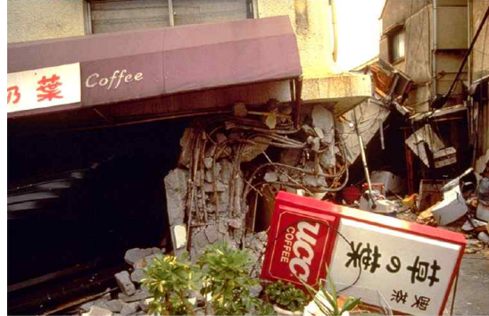
(a) 우리나라 저층 필로티형 집합주택 예 (b) 일본 고베지진(1995)에서의 필로티기둥 파괴 그림 1-5. 우리나라 저층 필로티형 집합주택과 해외의 대형 지진시 붕괴 사례
