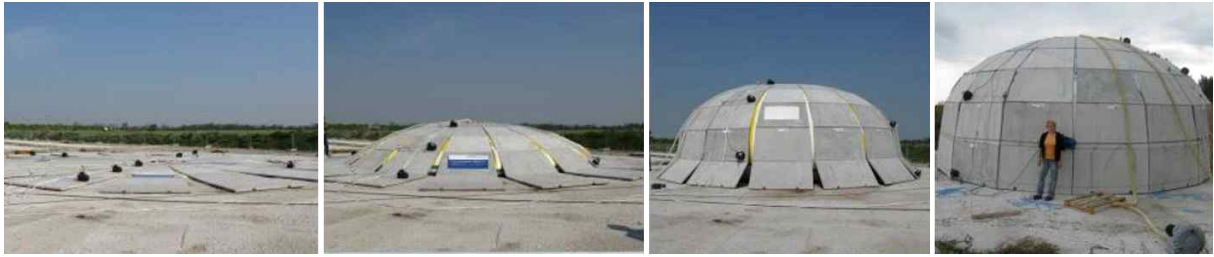
<그림 1-2-2> Pneumatic System(Latorre, 2010)
