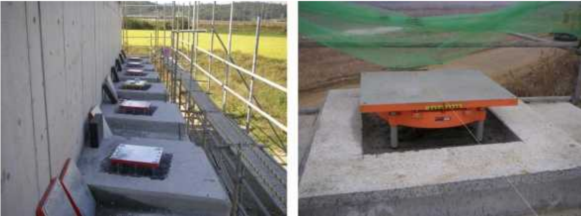
그림 2.3.32 포트받침의 현장 설치 사진 (선진산업개발)
