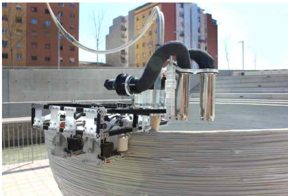
[그림 48] IAAC (Advanced Architecture of Catalonia)의 미니빌더스(Minibuilders)
