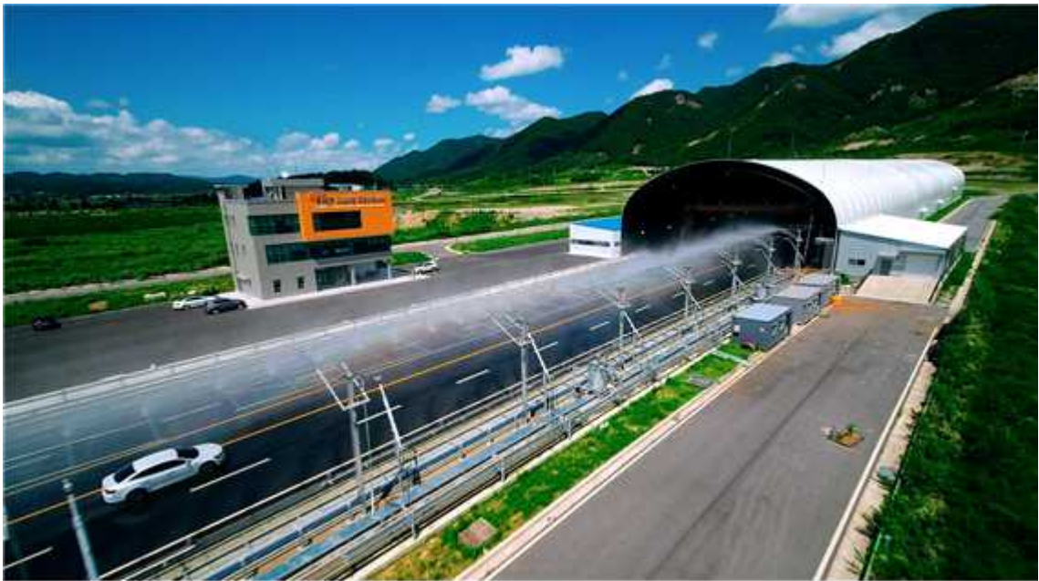
<그림 25> 강우 재현 실험시설 테스트(드론 촬영)
