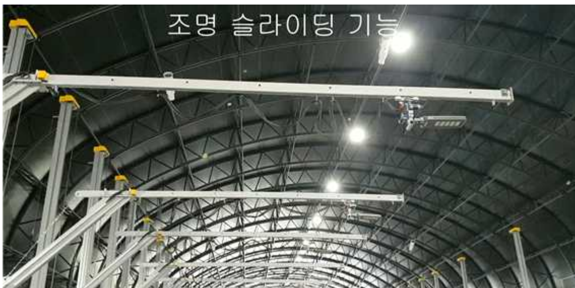
<그림 42> 조명등 위치 조절 기능 테스트(차로 안쪽 위치)
