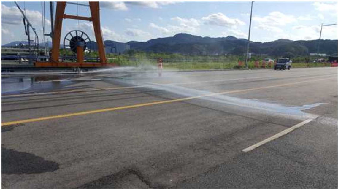
<그림 80> 용설제 성능평가 시험시설 살수 각도 및 분사거리 테스트
