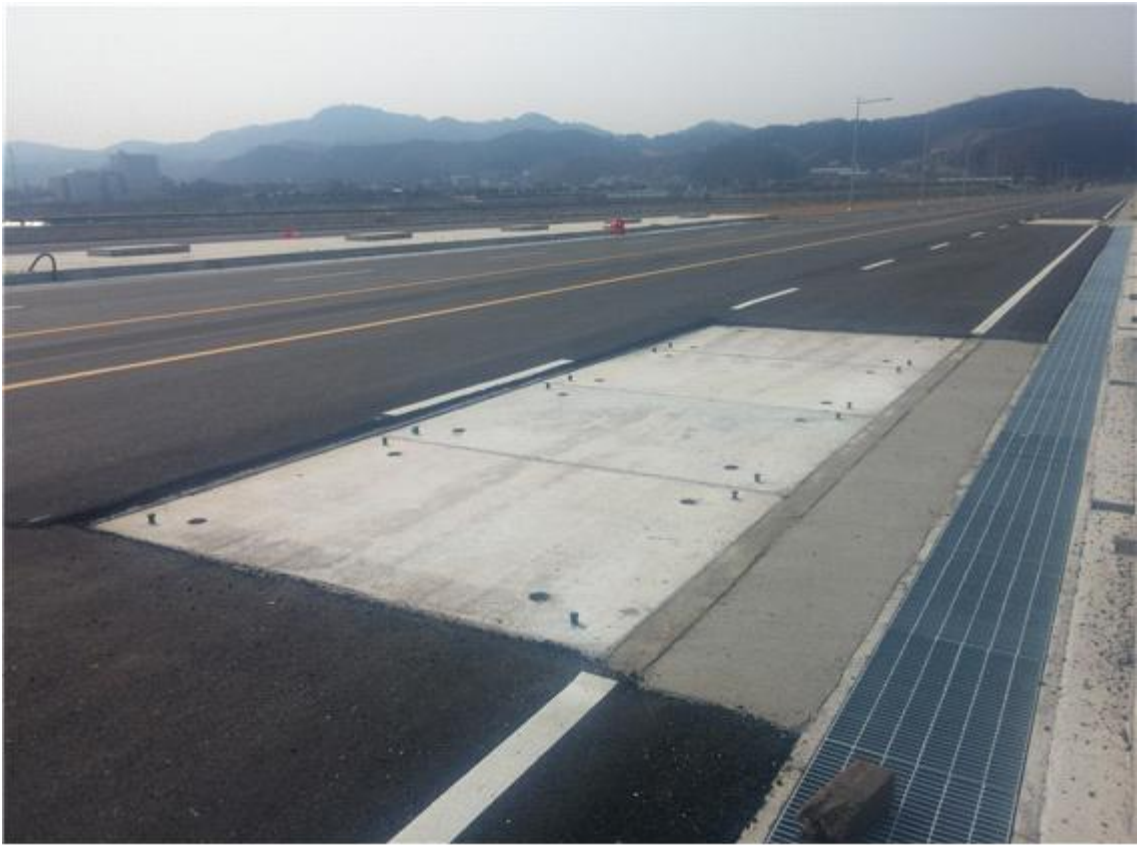
<그림 58> 기능성 포장 실험시설(노면 아스팔트 포장 전)
