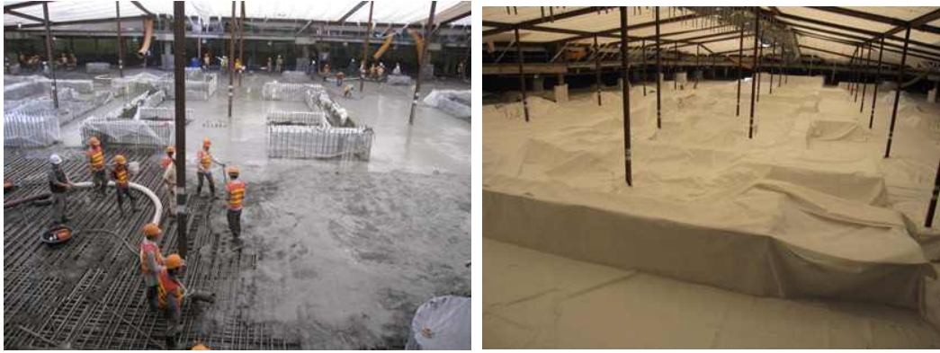
[그림 1.1] 인도차이나 반도 지역 현장의 기초 매트 콘크리트 타설 및 보양 시공 사례 ( 롯데센터 하노이 현장, 롯데건설)
