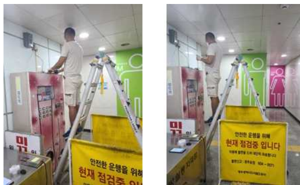
[Smart 중계기 현장설치 공사]
