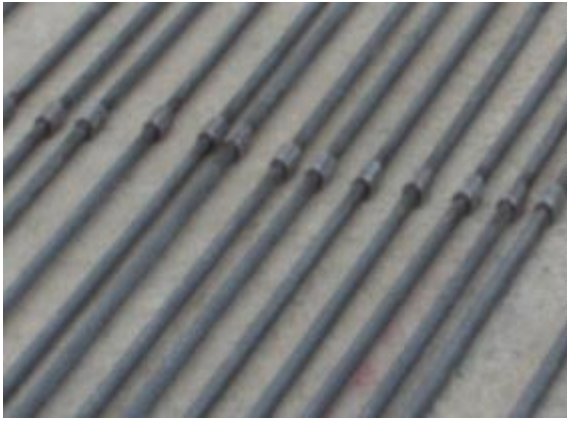
<그림 3.103> 커플러를 이용한 철근이음 전경
