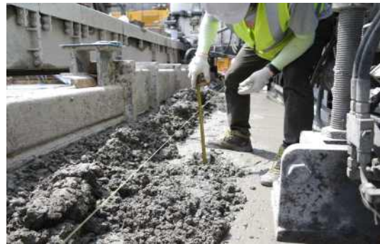
<그림 3.87> 시공 중 철근배근 깊이 확인
