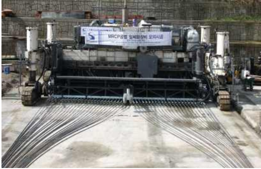
<그림 3.84> 포설 전 장비 및 철근배치
