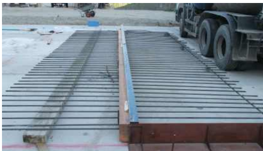
<그림 3.76> 시점부 철근 조립
