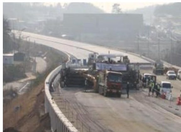
<그림 3.111> 콘크리트 포설 전경
