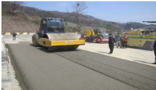
<그림 3.74> 린콘크리트 포설
