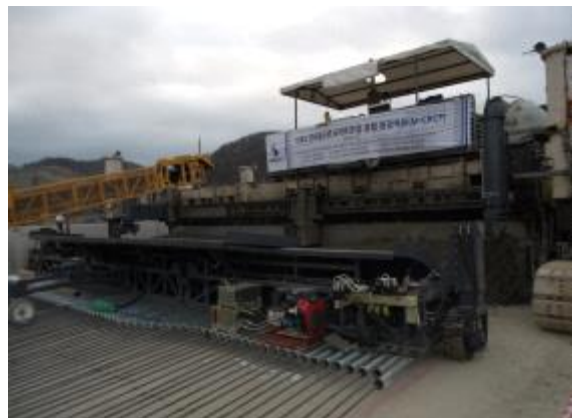
<그림 3.102> 철근유도장치 배치 및 철근 연결 전경
