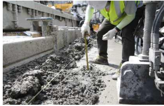
<그림 3.113> 시공 중 철근배근 깊이 확인
