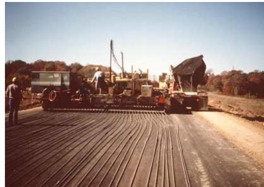
<그림 2.3> 기계식 방법 시공전경(미국)
