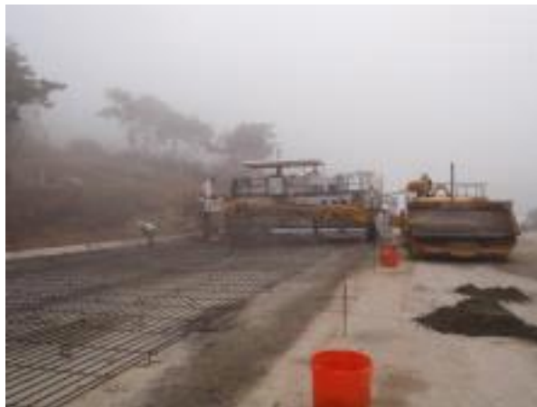
<그림 2.1> 음성-충주간 고속도로 CRCP 시공 전경
