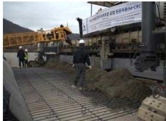
<그림 3.106> 시점부 콘크리트 포설(2)
