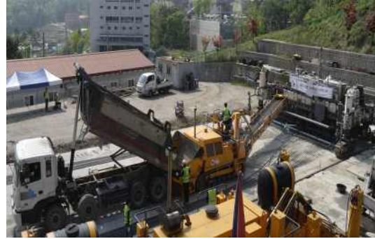
<그림 3.85> 콘크리트 포설 전경
