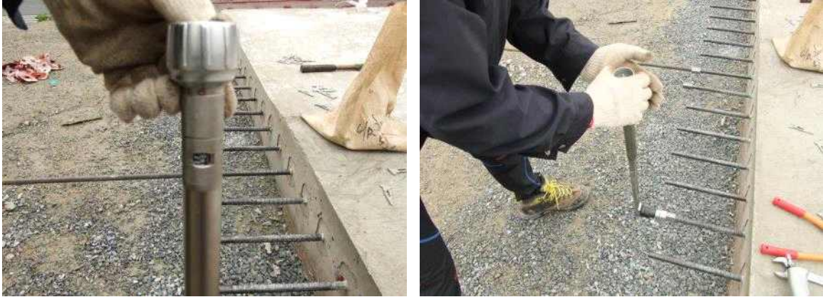
<그림 3.3> 철근의 기계식 이음시 안정성 검토 전경
