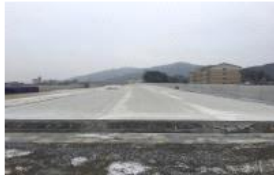
<그림 3.115> 시공완료 전경
