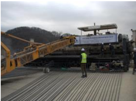
<그림 3.105> 시점부 콘크리트 포설(1)
