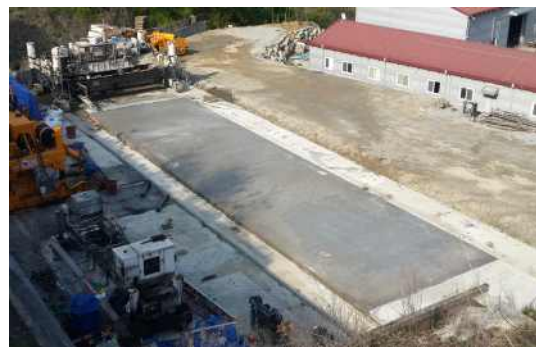
<그림 3.89> 시공완료 전경
