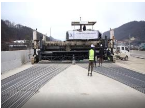
<그림 3.110> 포설 전 장비 및 철근배치
