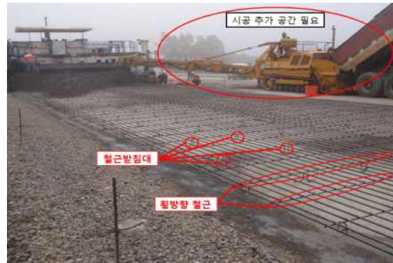
<그림 1.4> 음성-충주간 고속도로 CRCP시공전경
