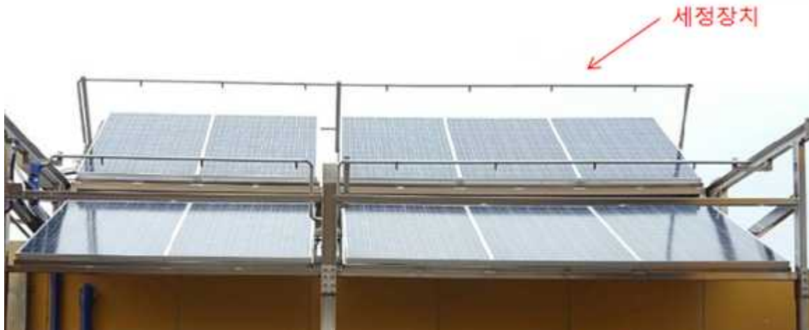
태양광 모듈 시스템 현장설치 모습 그림 3.5 태양광 모듈 시스템
