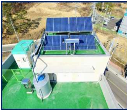
그림 3.7 태양광발전 기반 청정빗물집수장치 (함안, (주)산호수출포장)
