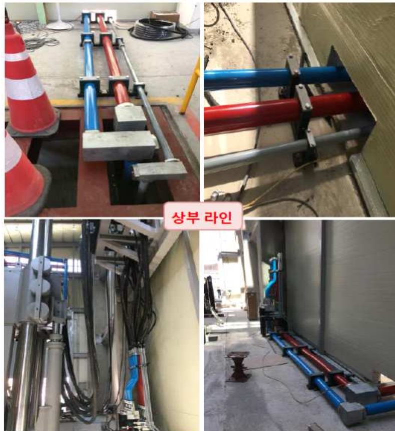
〈하드라인 설치 전경 - 지상 배관〉
