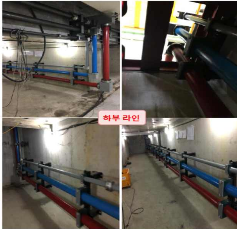
〈하드라인 설치 전경 - 지하 배관〉
