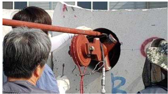
사진 26. 앵커풀리 설치
