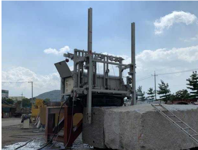
사진 36. 장심도 정위치 암반절단 공법 시험전경(2차)
