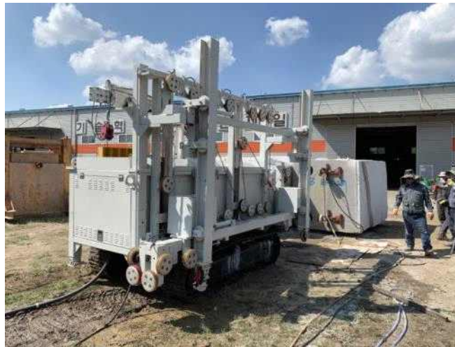
사진 45. 종방향 암반절단 기술 절단시험 전경
