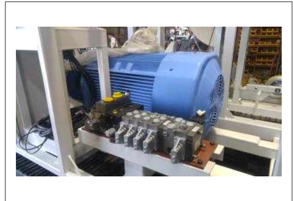
사진 4. 프레임상에 유압모터 설치
