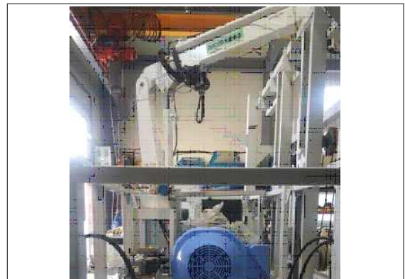
사진 6. 프레임상에 크레인 설치
