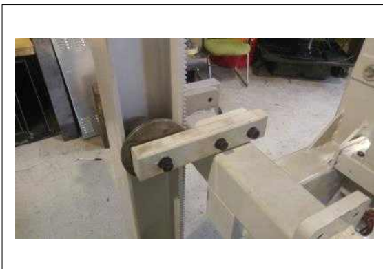
사진 7. 지지대 고정 장치 설치
