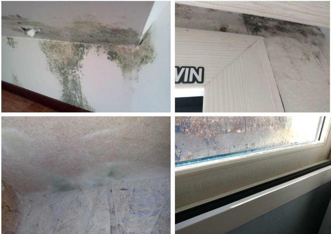
(그림 7) 국내 건축물의 습기로 인한 실내 하자발생사례 (출처 : 한국패시브건축협회 질문게시판)
