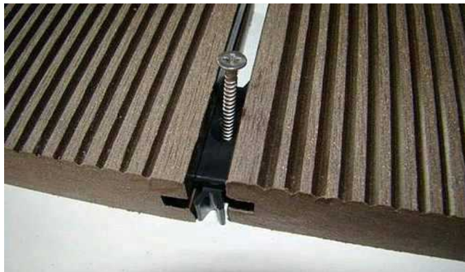
(그림 3.150) 마운팅클립에 철물못 시공>
