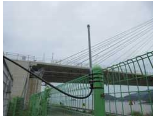
(d) 계측동 외부 안테나 설치
