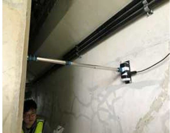
<그림 3.69> 신축변위계 설치 완료
