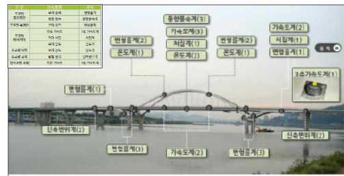
<그림 2.3> 현장계측장비 설치현황
