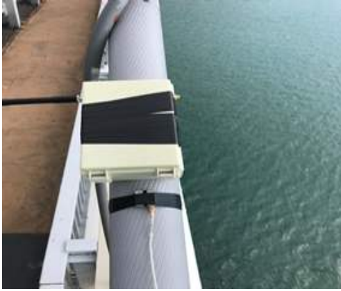
(a) 무선 계측기 / 유선 계측기 동시 설치
