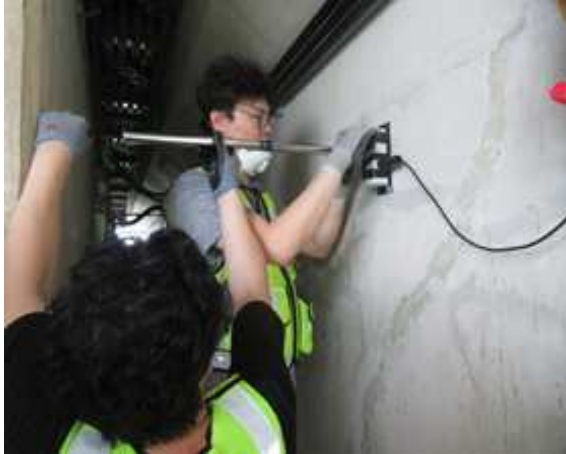
<그림 3.68> 신축변위계 설치
