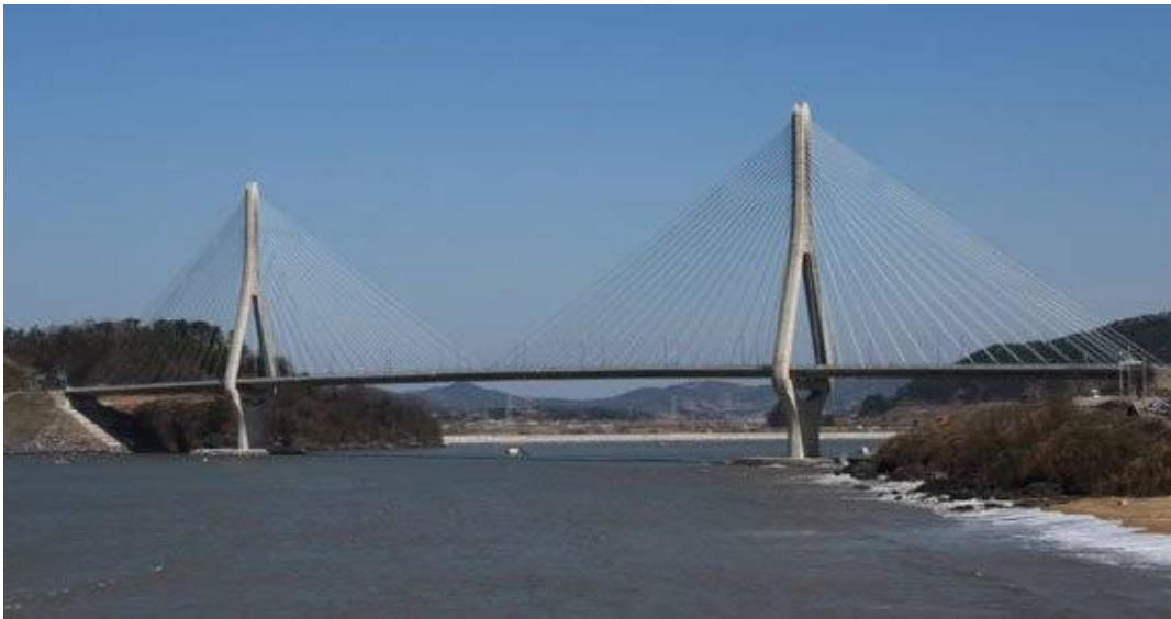
<그림 3.53> 테스트베드 영광대교 전경
