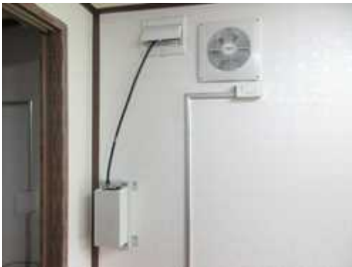
(a) 계측동 내부 게이트웨이 본체 설치
