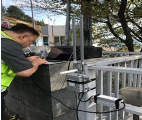
(c) 게이트웨이 설치 및 LoRa 서버 셋업
