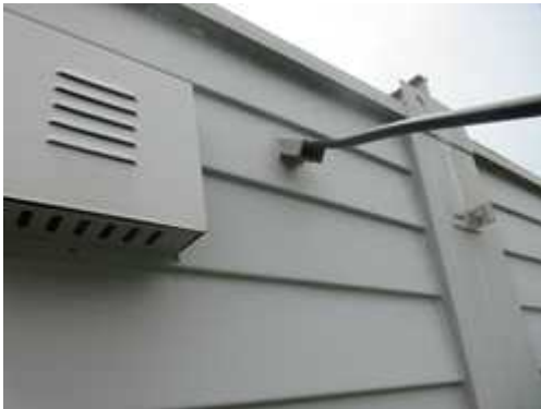
(c) 게이트웨이 안테나 익스텐션 설치
