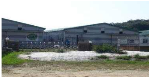
전경 및 외부 담장
