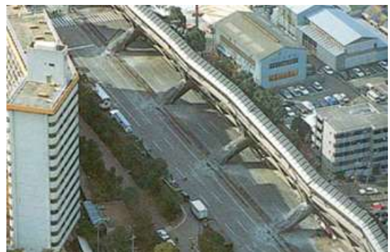
그림 43. 얇은 기초의 현행 내진설계 개념 그림 44. 현행 설계 개념으로 설계된 교량의 붕괴
