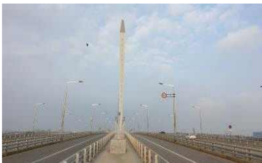
(d) D Bridge Panorama
