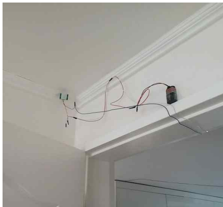
(a) PIR 센서 설치 (안방)
