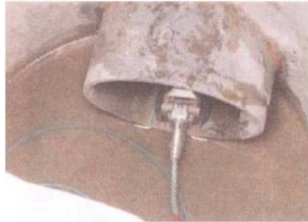
사진 4-1 자주식 카메라를 이용한 U자구 점검
