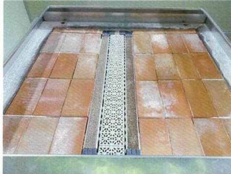
<집수로 설치 보통블록>
