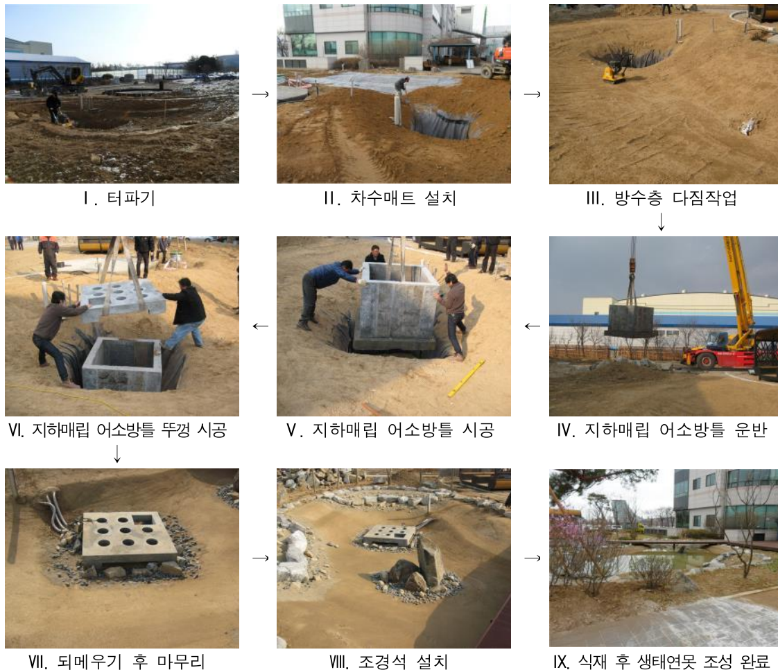
<그림3.5.2> KICT 커뮤니티가든 생태연못 시공 절차.
