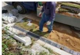
6. 식생블록 및 투수블록 설치
