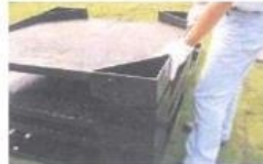
사진 3-7 경사재의 설치
