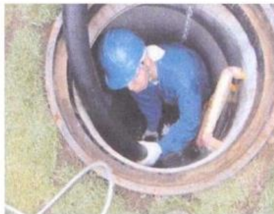
사진 4-5 슬러지 흡인차에 의한 모래나 쓰레기 흡인과정
