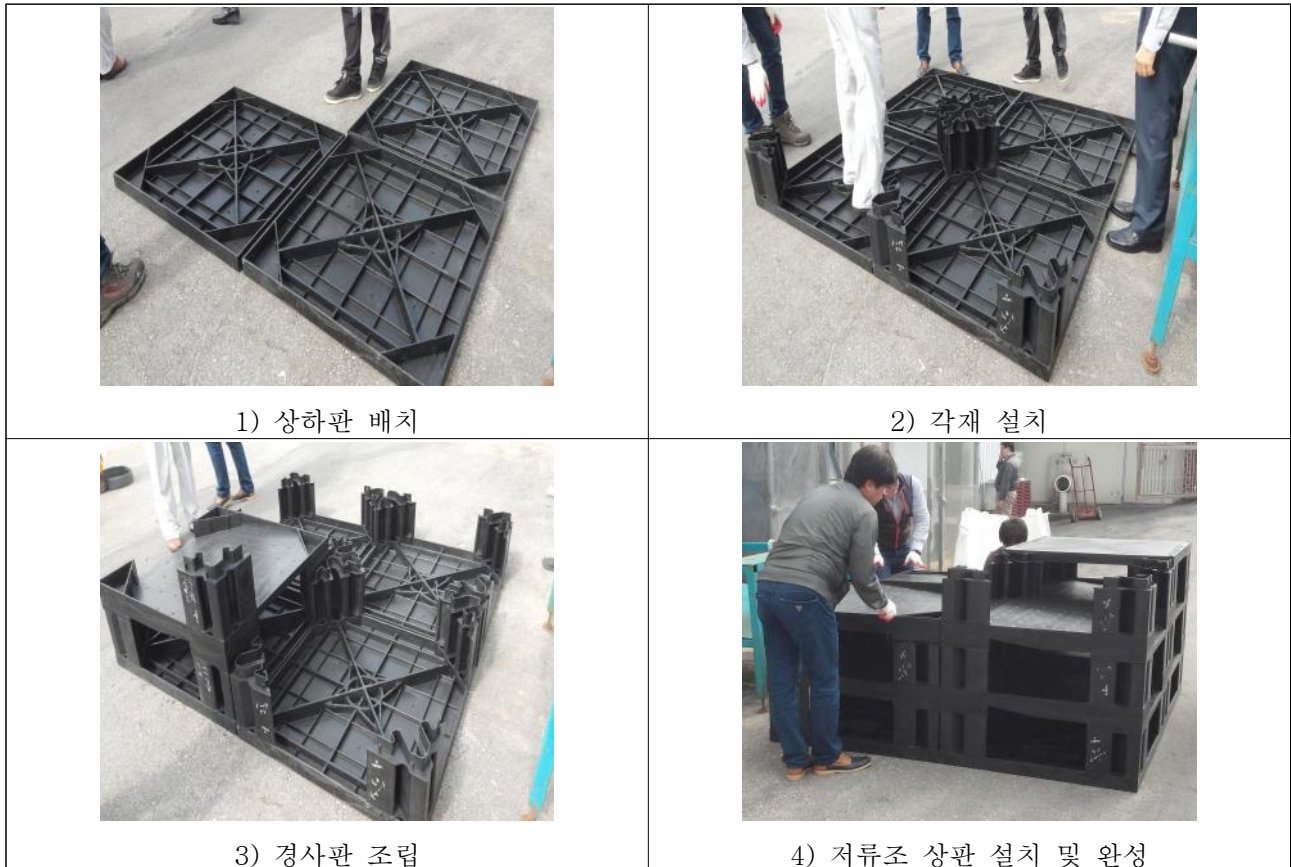
<그림3.1.47> 개선된 GMT 빗물저류조 조립 시험시공
