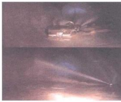
사진 4-3 고압노즐에 의한 U자구의 세정상황
