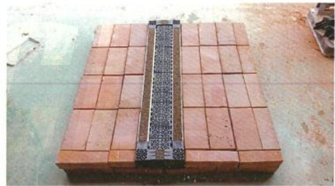
<집수로 설치 보통블록>
