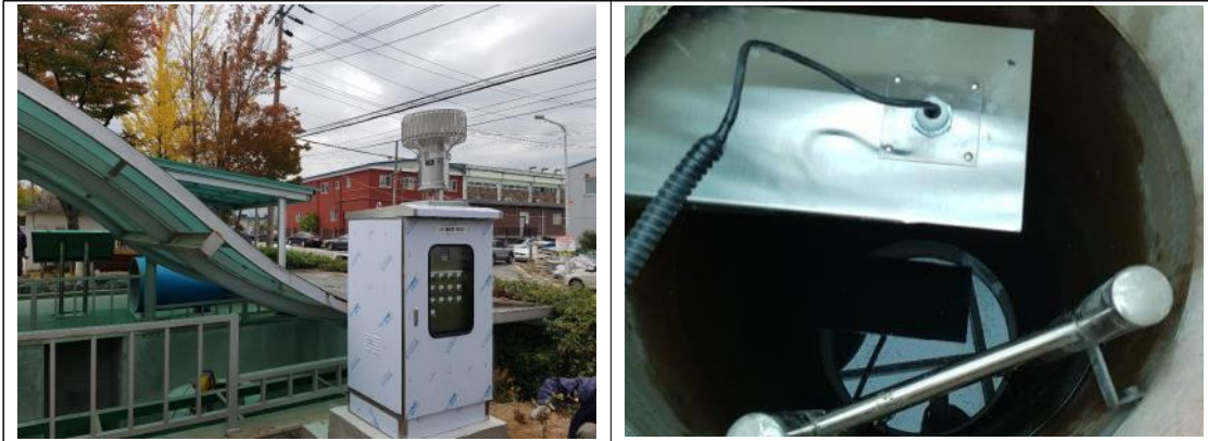
<그림3.6.7> TestBed 현장 제어반 및 계측기 설치
