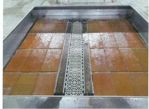
<집수로 설치 보통블록>
