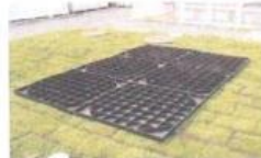
사진 3-5 판재의 설치
