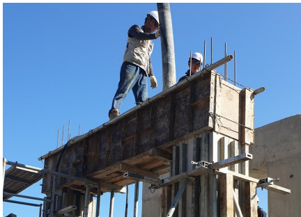
(g) 콘크리트 타설
