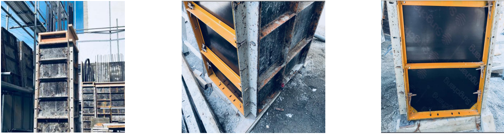
[그림 2.92] 유로폼을 이용한 중소규모 RC 구조물 1층 필로티 기둥의 거푸집 설치 작업 사례
