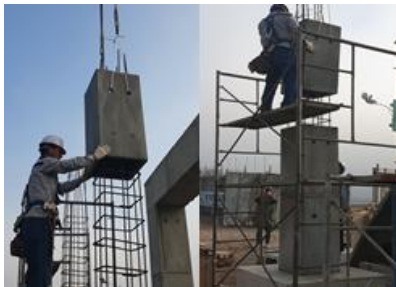
(d) TRC 영구거푸집 모듈 설치
