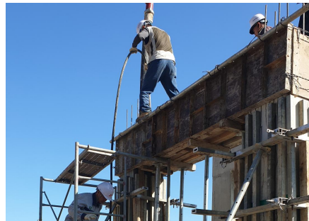
(f) 콘크리트 진동 및 다짐
