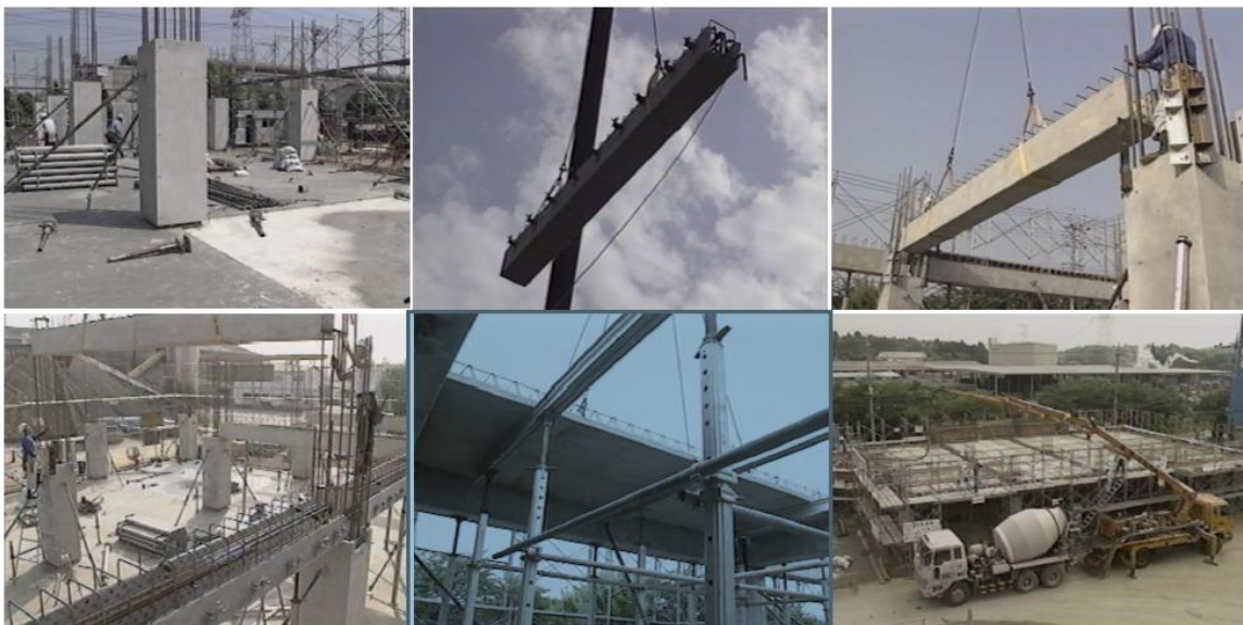
[그림 2.93] 비탈형 영구 거푸집의 현장 설치 사례
