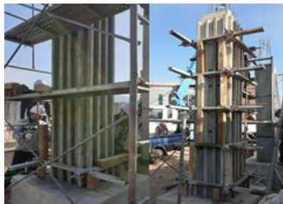
(e) TRC 영구거푸집 모듈 수직 보강
