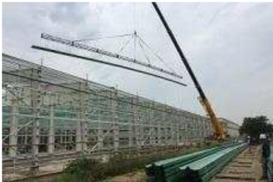
외장재 및 지붕 판넬공사
