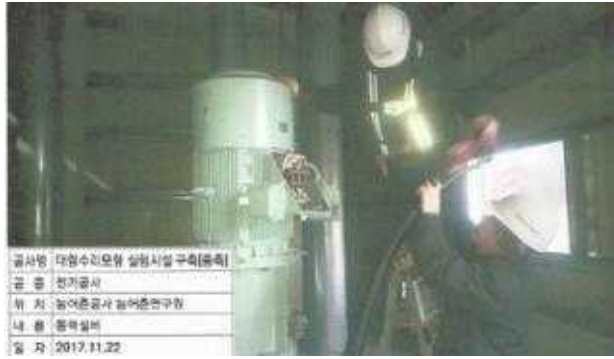
전기 동력설비 공사
