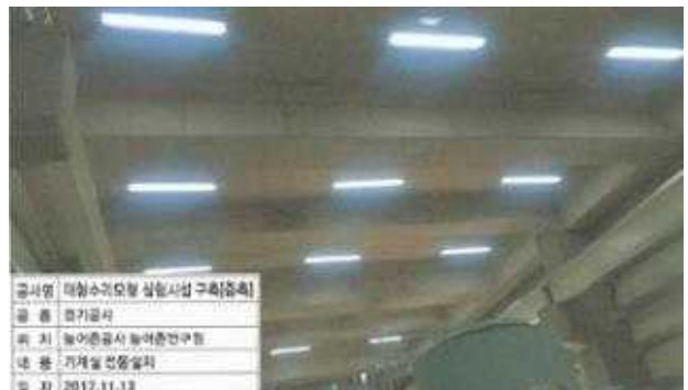
내부 전등기구 설치
