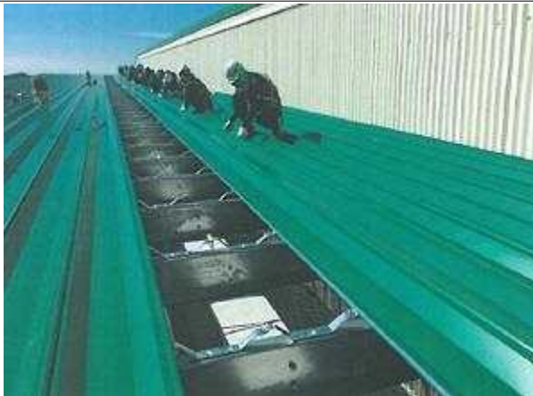
외장재 및 지붕 판넬공사
