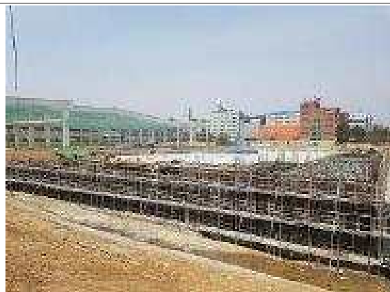
지하저수조 1층 슬라브 설치
