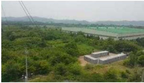
현장사무소 설치(2차년도 완료)
