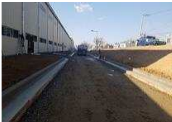
부대토목 - 경계석 설치
