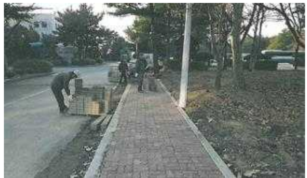
부대토목 - 보도블럭 설치 완료
