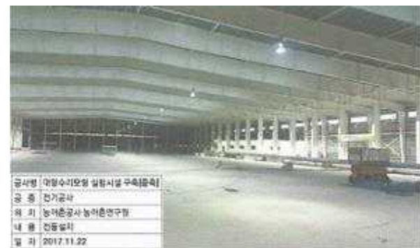
내부 전등기구 설치
