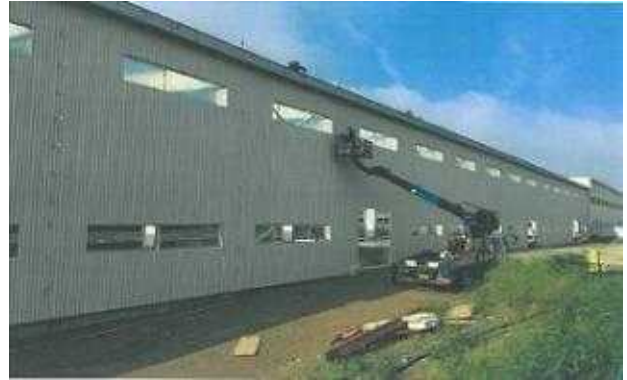
외장재 및 지붕 판넬공사
