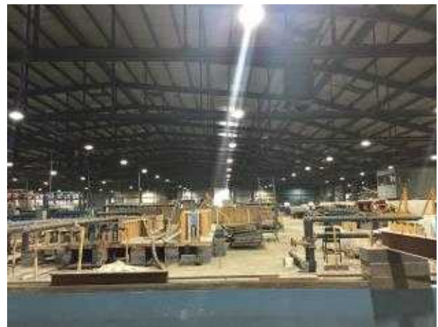
월링포드 수리시험장 전경
