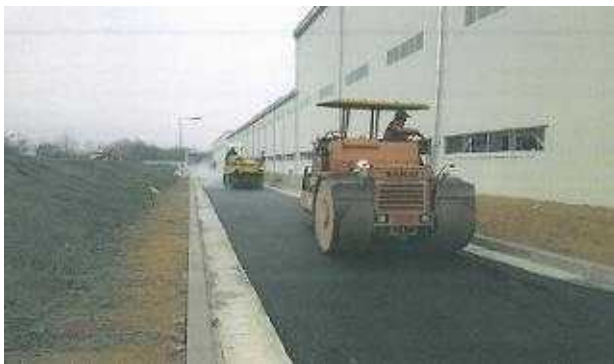
부대토목 - 아스팔트 포장 완료
