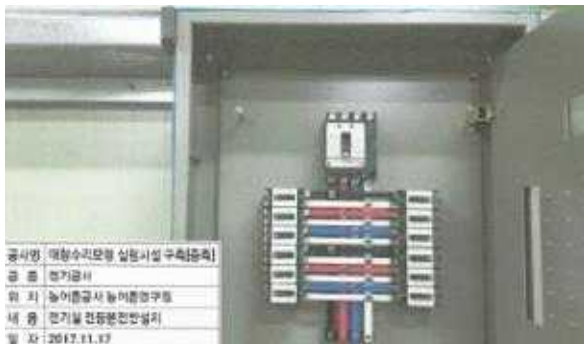
전기실 전등분전반 설치
