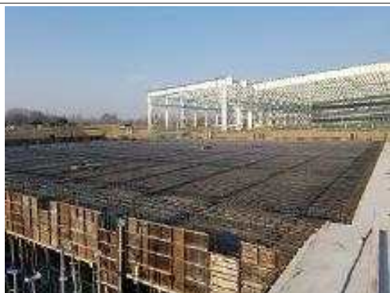
지하저수조 1층 슬라브 설치
