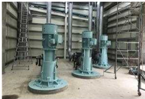
입축사류펌프 및 전동기 설치 완료
