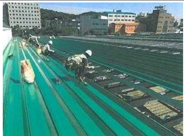
외장재 및 지붕 판넬공사
