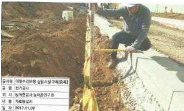
옥외 가로등 설치
