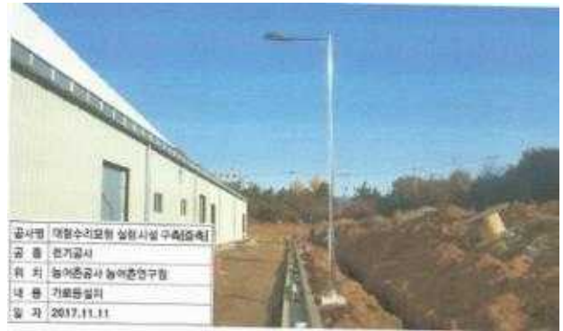
옥외 가로등 설치
