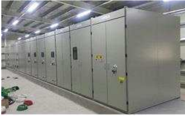
수배전반 및 MCC반 판넬 설치
