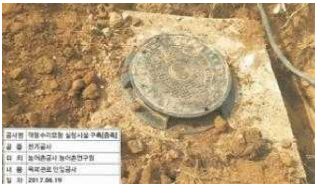
전기 옥외관로 인입공사
