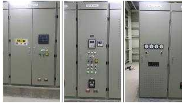
수배전반 및 MCC반 판넬 설치
