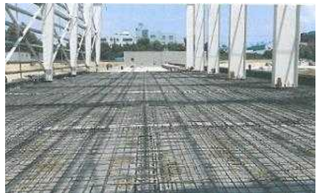
계측실 및 홍보용데크 철근콘크리트 공사
