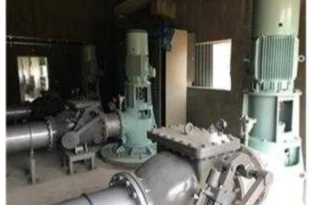
입축사류펌프 및 전동기 설치 완료
