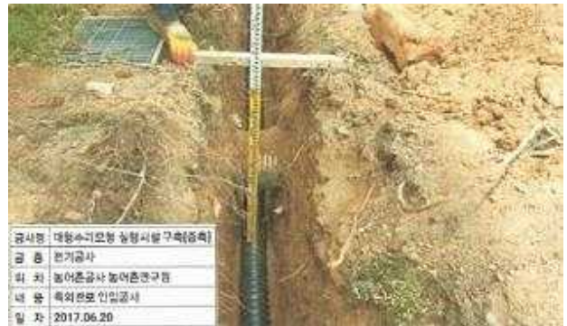
전기 옥외관로 인입공사
