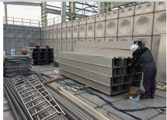
고수조 물탱크 조립
