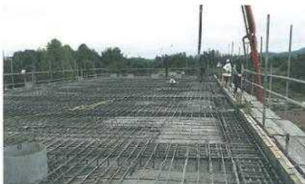
고수조2 슬라브 철근콘크리트 공사
