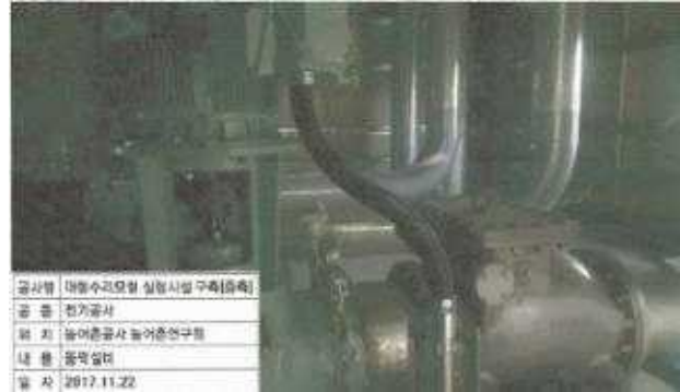
전기 동력설비 공사
