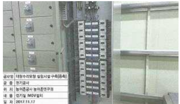
전기실 MOV 설치
