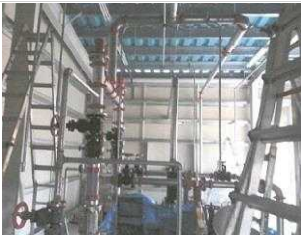
소방설비 배관 및 장비 설치공사
