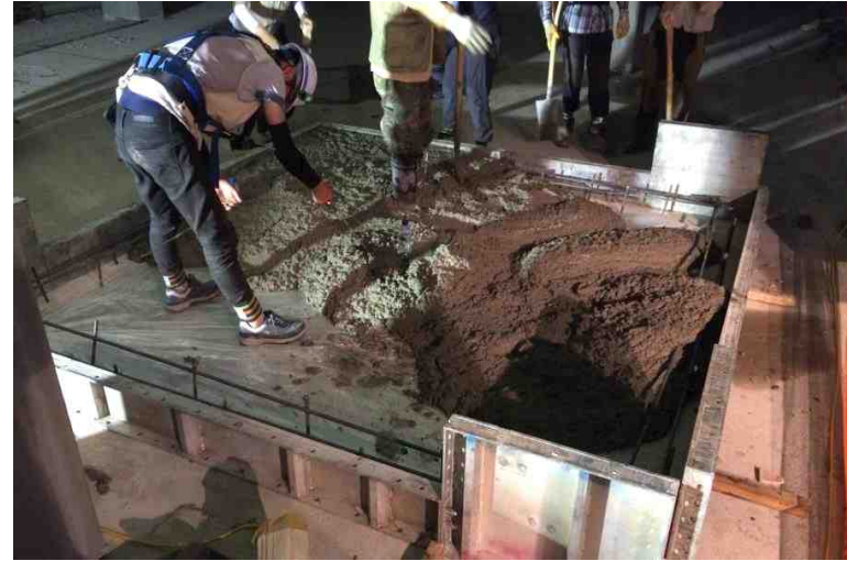
콘크리트 현장 타설
