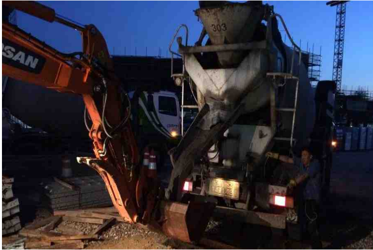
콘크리트 현장 토출
