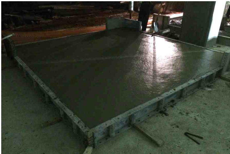
모의부재 Slab type 타설 완료
