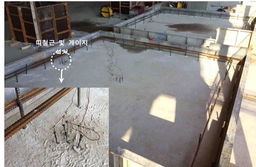
모의부재 제작 전경(Slab type) (2)
