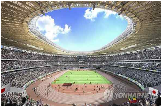
도쿄올림픽 주경기장의 목조 지붕
