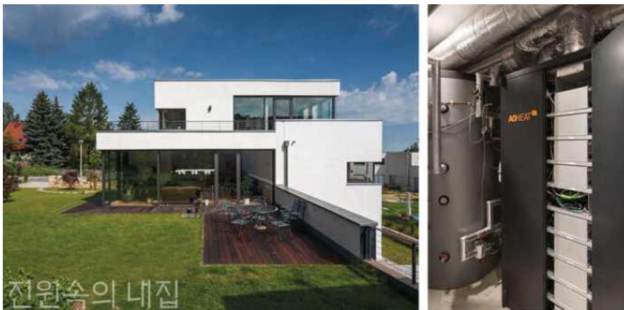
[그림 4.34] 컴퓨터 서버룸에서 발생하는 폐열을 회수해 에너지원으로 사용하는 예시
