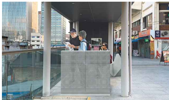
[그림 4.19] 빛과 형상이 은은하게 비치는 투광성 콘크리트
