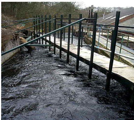
그림 2.1.6 소용돌이를 이용한 어류 차단시설(Environment Agency, 2005)
