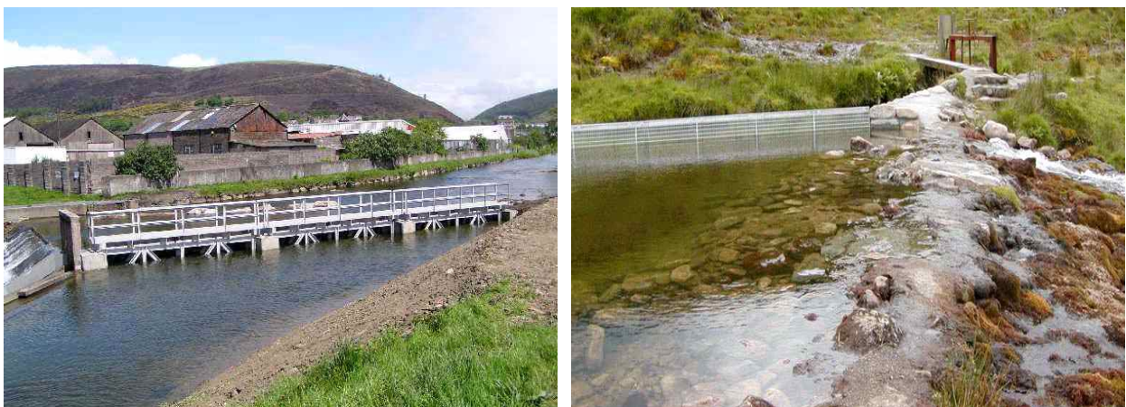
그림 2.1.1 어류차단을 위해 설치된 고정용 판넬 스크린(Environment Agency, 2005)
