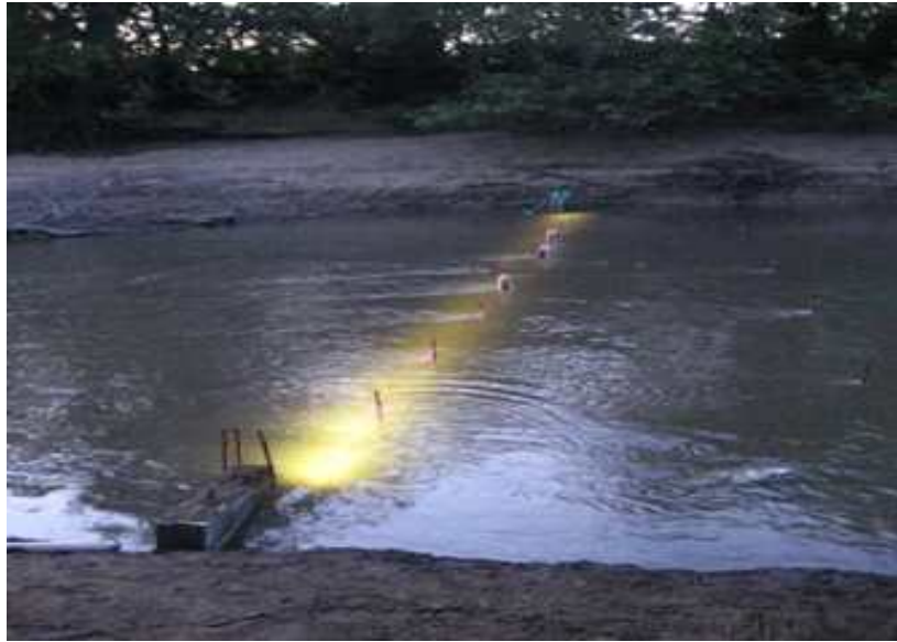
그림 2.1.9 빛을 이용한 어류 차단시설(Environment Agency, 2005)
