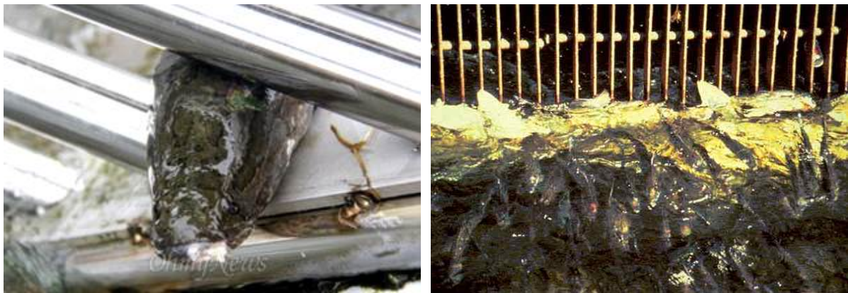
그림 2.1.12 직접차단시설의 단점(오마이뉴스(좌), 2013; ASCE, 1995(우))
