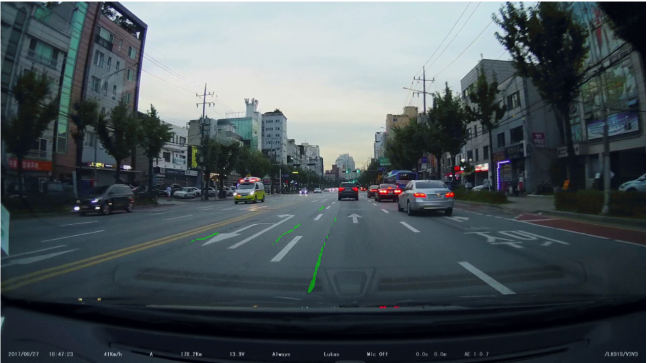
[그림 2-16] 도로 포장 픽셀 단위 균열 검출 예시.
