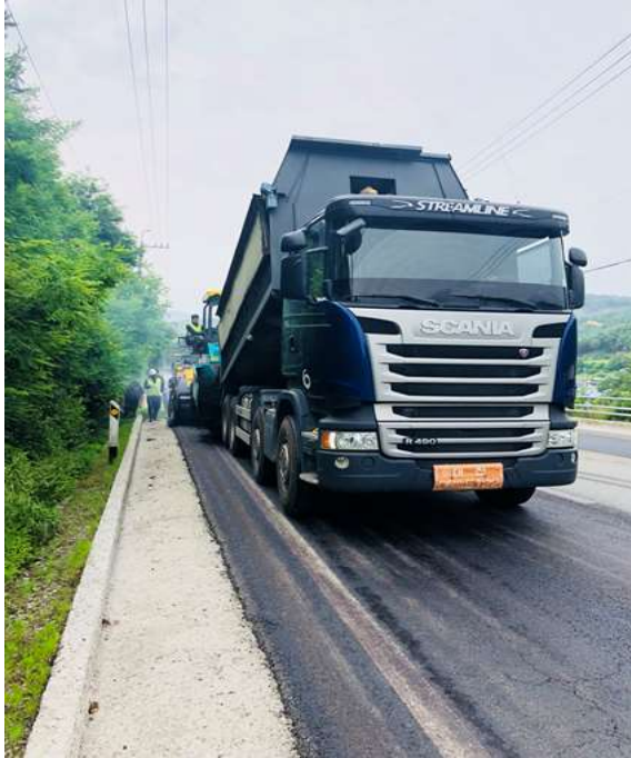
그림.96 아스팔트 콘크리트 운반
