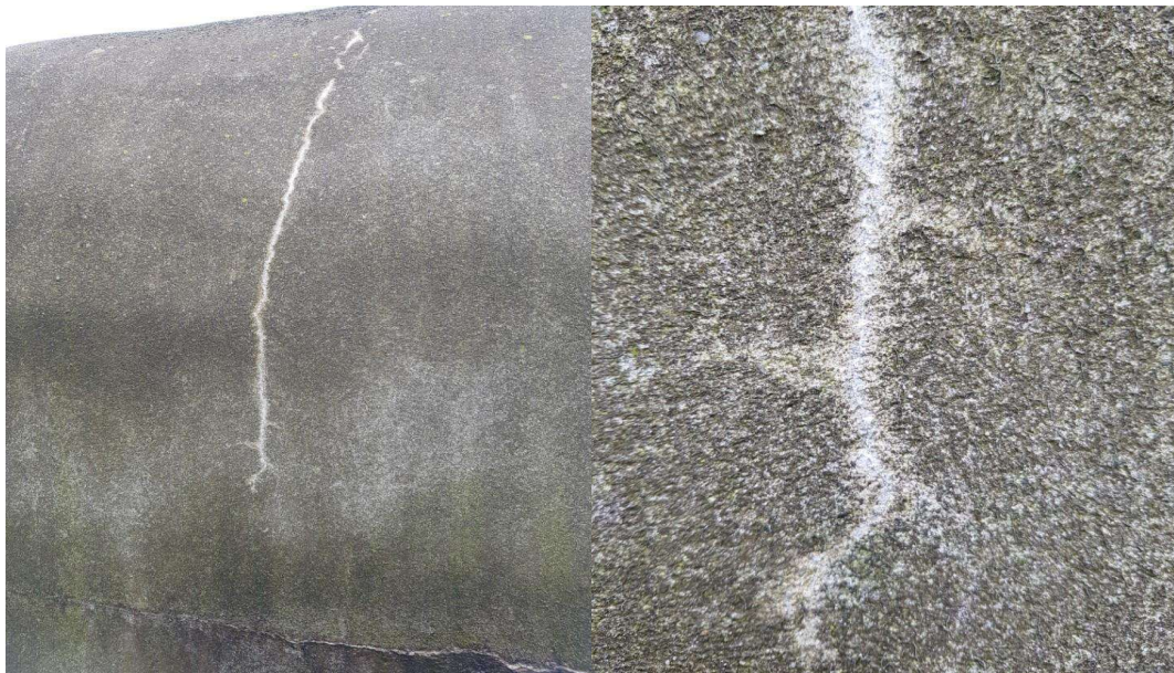
그림.101 박테리아를 활용한 콘크리트 자가 치유
