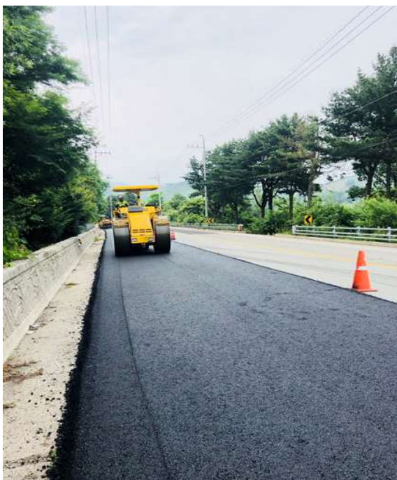
그림.98 아스팔트 콘크리트 다짐
