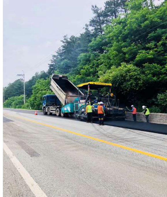
그림.97 아스팔트 콘크리트 타설
