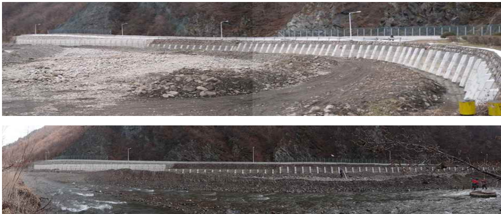
< 속저감시설 시범설치 전경(태백황지천 수해피해 복구현장)>
