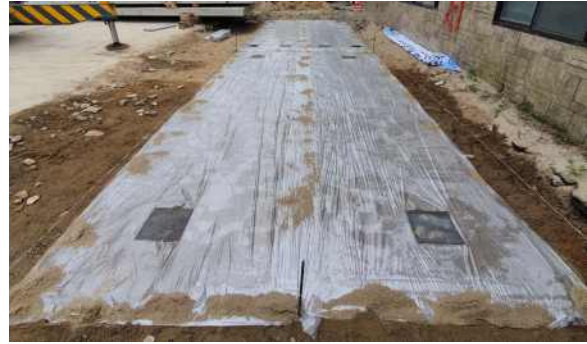
(b) 비닐포설 및 높낮이조절판 설치
