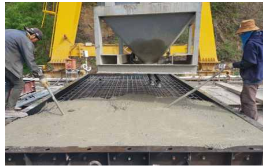
(b) 전단면 패널 콘크리트 타설
