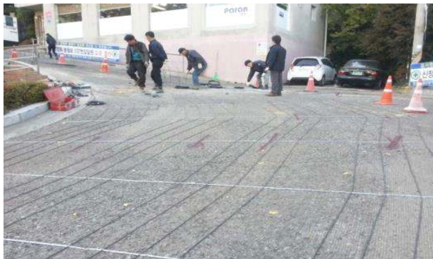
그림 1.4 도로 열선을 설치하는 모습
