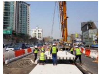
콘크리트 패널 급속시공
