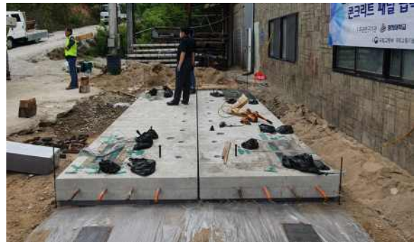
(d) 반단면 패널 설치
