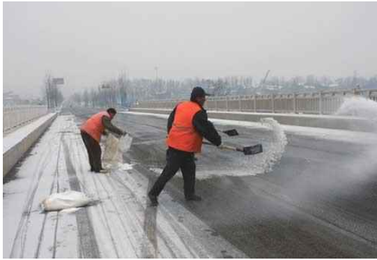
그림 1.2 제설제를 살포하는 모습
