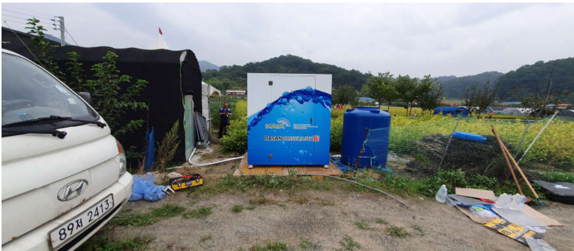
<그림 39> 설치 전경
