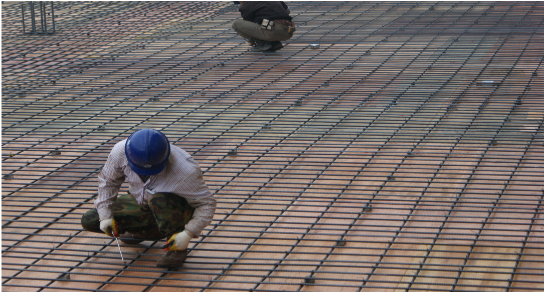
〈그림 II-15〉 하부철근을 설치하고 스페이서로 바닥에 고정시키는 작업
