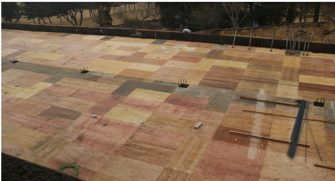
〈그림 II-14〉 거푸집 설치 후의 전경
