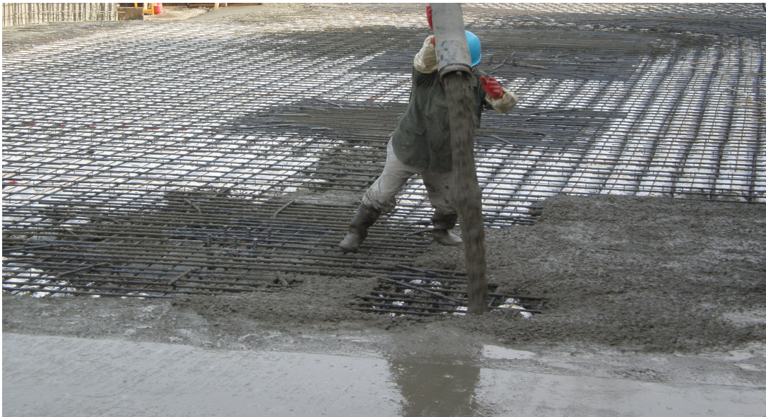
〈그림 II-18〉 콘크리트 펌프를 이용한 타설
