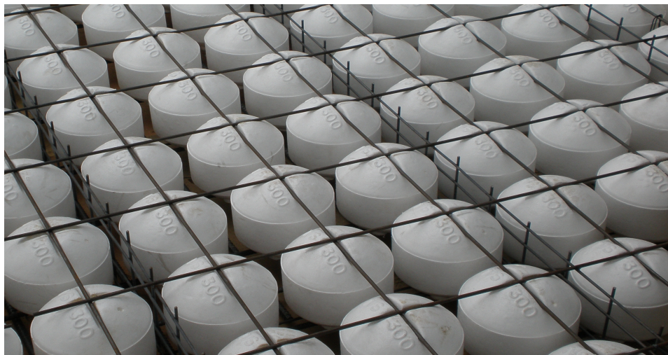
〈그림 II-7〉 와이어 메쉬를 이용한 경량체의 조립
