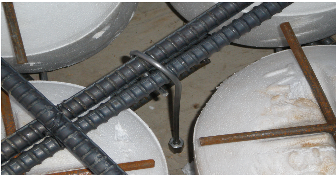
〈그림 II-17〉 부력에 의한 경량체의 부상을 방지하기 위한 고정장치
