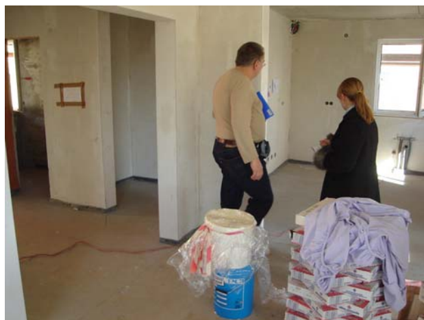
[그림 6.2.21] 압력검사에 의한 배관누수 상태 및 난방성능 확인
