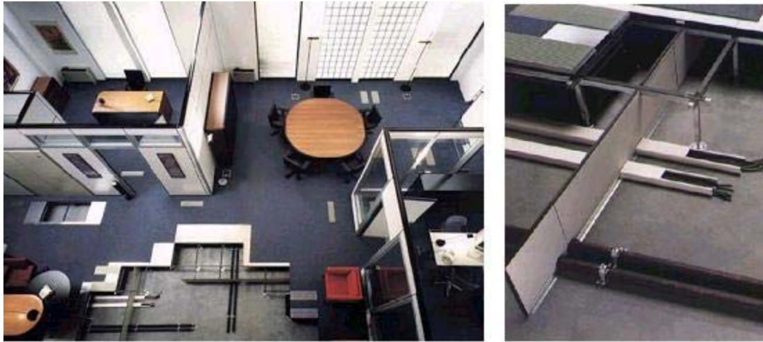
[그림 2.2.14] 환기효율이 높은 바닥급기-천장배기방식의 환기시스템
