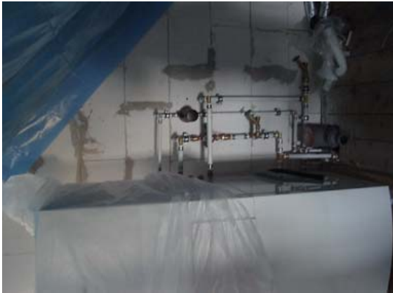
[그림 6.2.13] 콘덴싱보일러 설치
