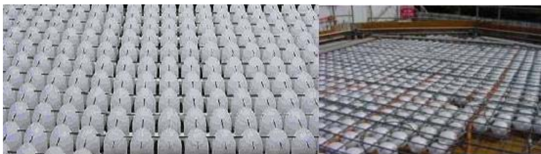
[그림 2.2.8] 슬래브두께를 225~375mm까지 조절가능한 볼보이드 중공슬래브공법
