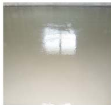
9 미장 / 시공 완료
