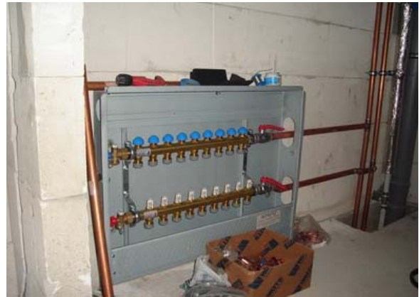
[그림 6.2.14] 바닥 난방용 분배기 설치
