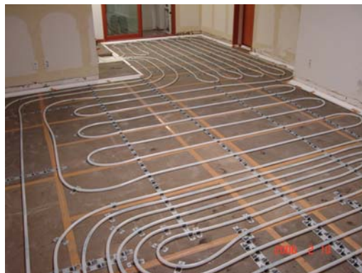
(d) 크립바 및 온수배관 설치 공정
