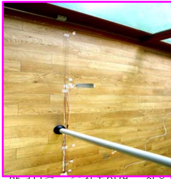
말고니측 수직높이별 실온 및 바닥표면온도 측정 바닥표면온도센서 설치
