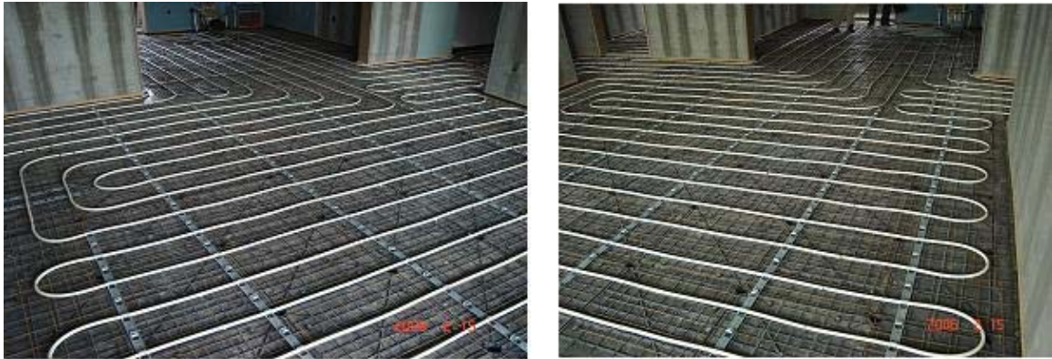
[그림 3.5.8] 거실에 설치된 이중바닥 온돌시스템 및 배관재 설치 모습
