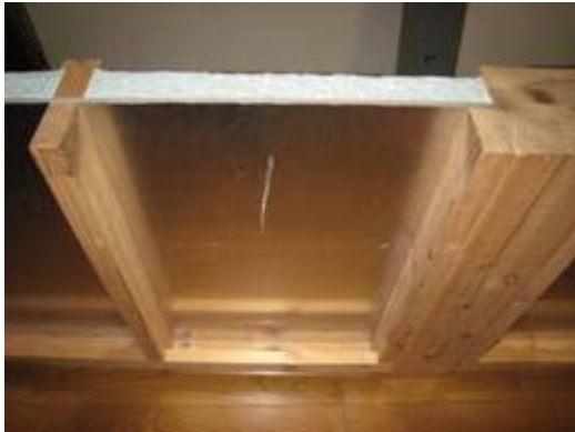
[그림 3.8.22] 구조체(벽체)일체형 단열 패널
