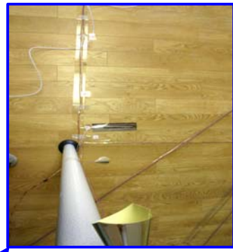
주방측 수직높이별 실온 및 바닥표면온도 측정 바닥표면온도 센서 설치
