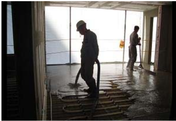
[그림 3.2.4] 모르터 시공
