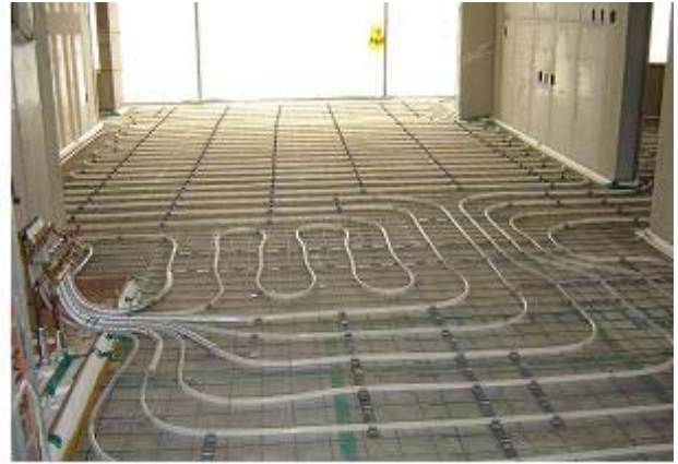
[그림 3.2.3] 이중바닥온돌시스템 설치
