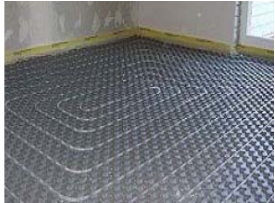
[그림 6.2.17] 바닥 난방배관 설치
