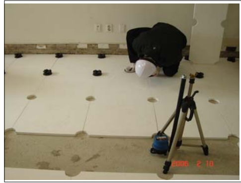
b) 방진재 및 조절대 설치 공정
