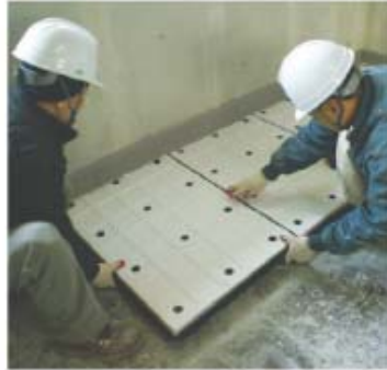
2 SI 패널조립 시공1
