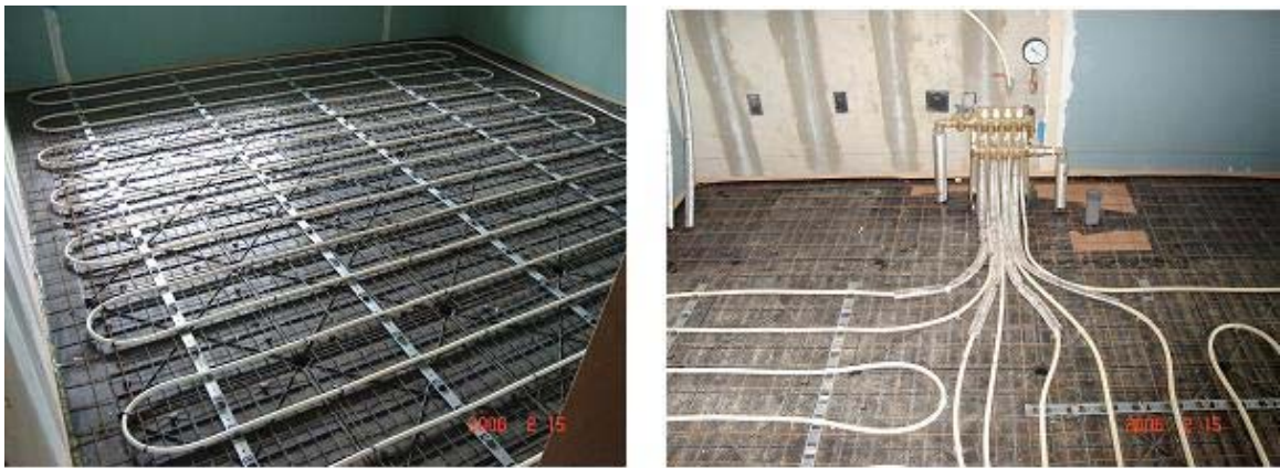
[그림 3.5.9] 침실과 주방에 설치된 이중바닥 온돌시스템 및 배관재 설치 모습
