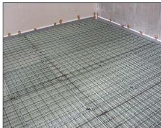
(c) 난방패널이 설치된 상태
