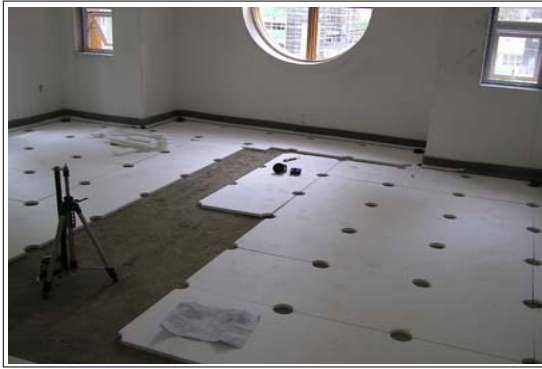
a) 단열재 및 측면완충재 설치 공정
