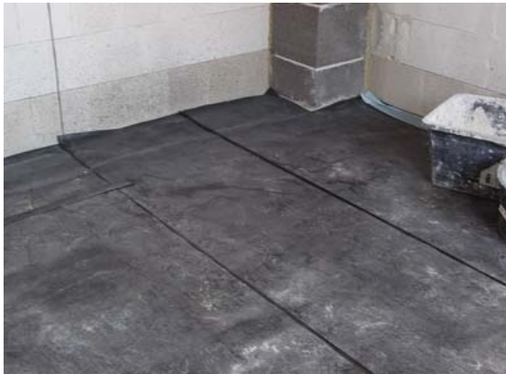
[그림 6.2.15] 바닥 난방 방수포 설치
