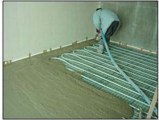
(d) 온수배관 설치 및 마감모르터 타설 공정
