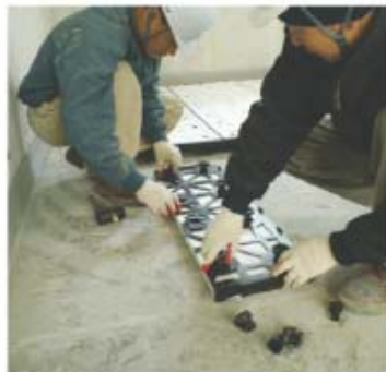
5 이형부위 가공 / 조립시공
