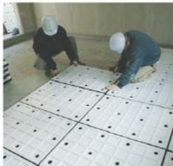
4 SI 패널조립 시공2
