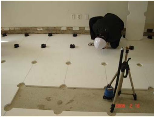
(a) 단열재 및 방진재 · 조절대 설치 공정
