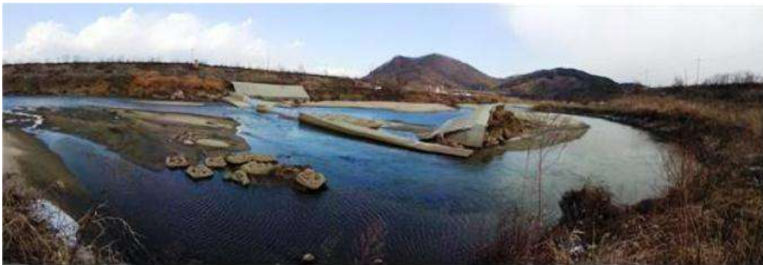
<그림 1.1.2> 하천환경사업 후 붕괴된 하천시설물의 모습(금강 지류 유구천, 2013)
