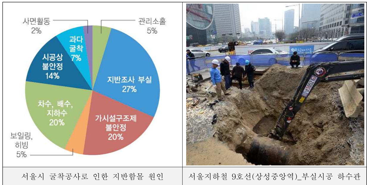
[그림 1-13] 출처: 싱크홀 진단과 대책 정책 토론회(서울시)
