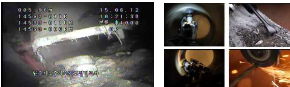
[그림 1-17] 하수관 내 장애물 확인 및 제거(출처: 원주시노후하수관 정밀조사 보고서 2015년)
