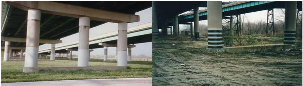
그림 12. 기둥에 면진장치 설치 사진(미국, 일리노이주)
