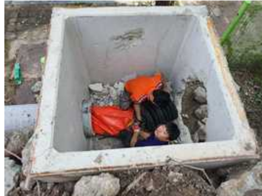
② 토목섬유 튜브와 주입관 설치
