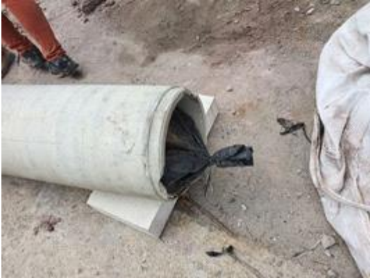
⑤ 토목섬유 튜브 및 압력커튼 설치 완료
