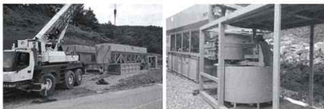
그림 1. 장비 설치 장면
