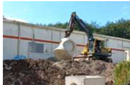
② 맨홀 설치
