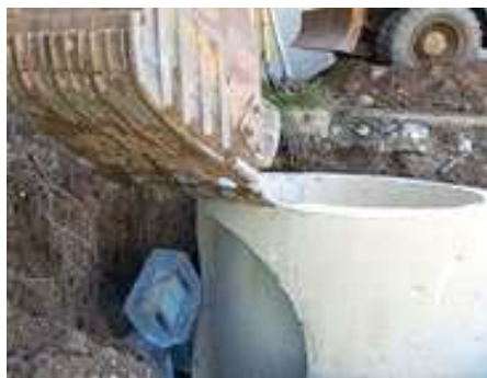
③ 맨홀 인접 공동 생성용 얼음 설치
