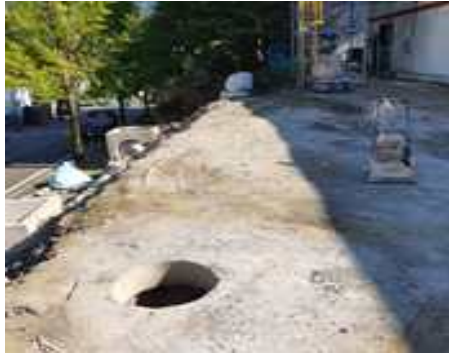
⑦ TEST-BED 현장 조성 완료
