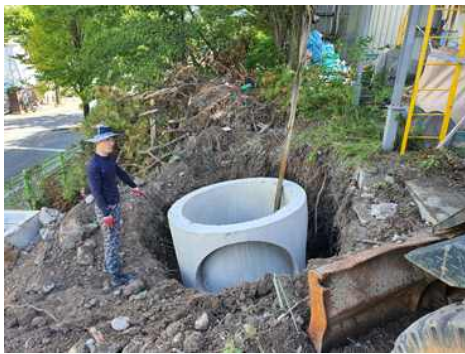
① 맨홀 설치
