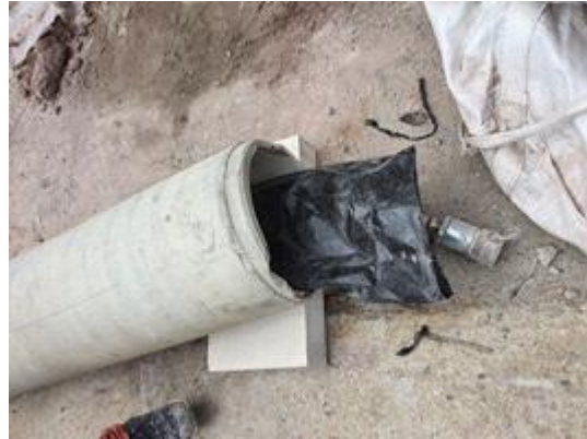
② 토목섬유 튜브와 주입관 설치
