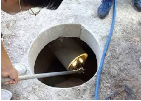
① 관로 내부 CCTV 차량 조사
