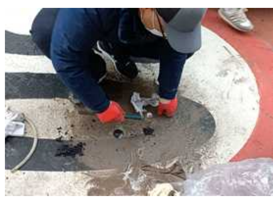
⑧ 주입공 및 오버플로우공 마감
