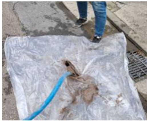
④ 주입관 설치
