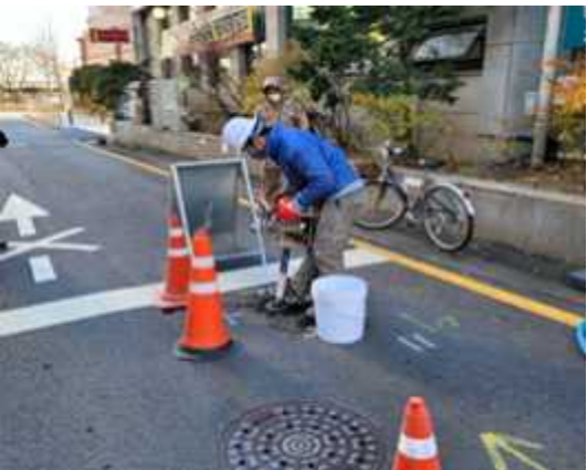
③ 주입공 및 오버플로우공 천공
