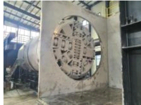
<실대형 쉴드TBM 굴진실험>
