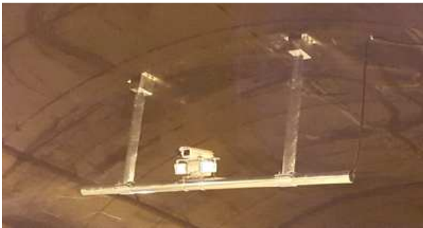
그림 171 한국도로공사 위반차량단속용 융복합 시스템(창원터널 설치)
