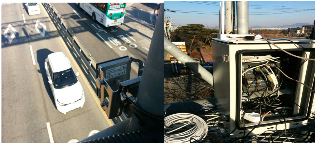
그림 79 레이더 설치
