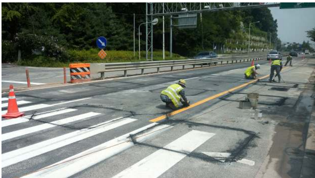
그림 77 루프검지기 설치 공사
