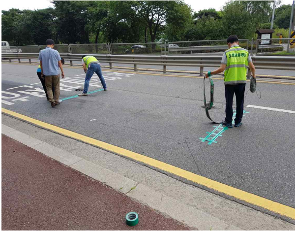
그림 121 기준장비 테이프스위치 설치
