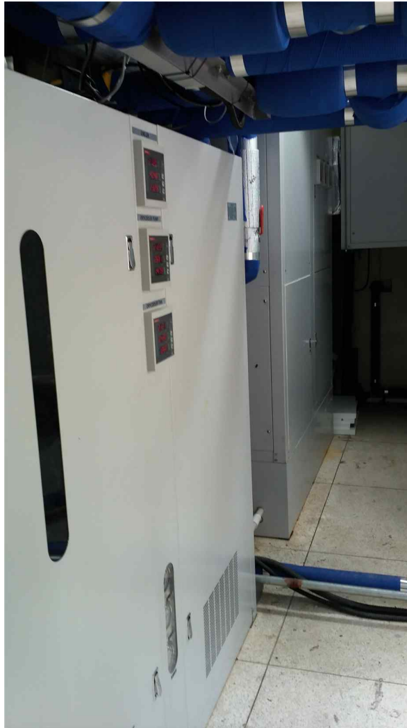
[사진 3.1.3] 멀티 외기냉방형 CRAC의 외관
