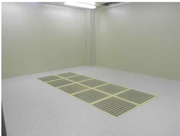
[사진 3.1.4] 테스트 베드 내부 (건축공사)
