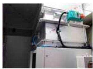
외기 덕트 FMS 사진 [2.3.1] 테스트 베드 시공 (1)
