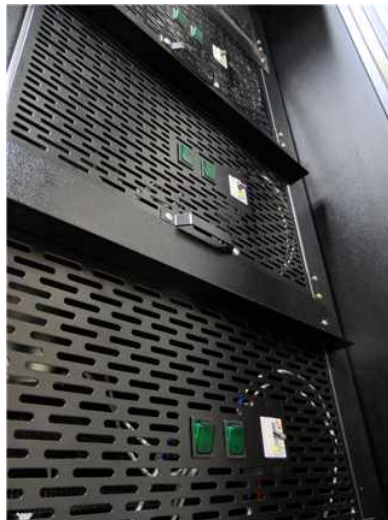
배플 (baffle) 설치 모습
