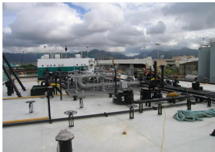
<그림 3-2> Line blender 설치된 barge
