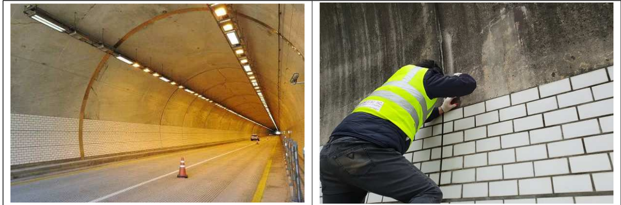
〈그림 2-34〉 봉산터널 현장 영상 촬영
