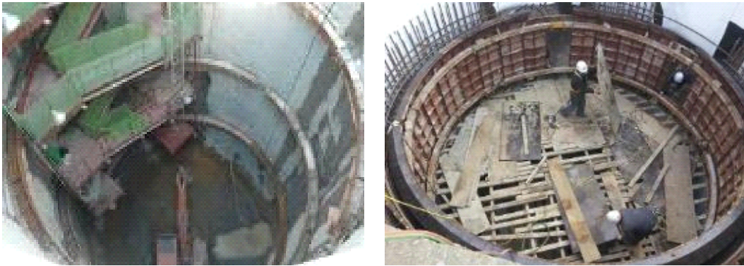
<그림 1.2.4> 수직구 굴착 및 구조물 시공
