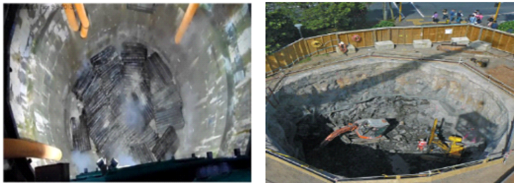
<그림 1.2.3> 발파(좌측) 및 할암기(우측)를 이용한 수직구 굴착
