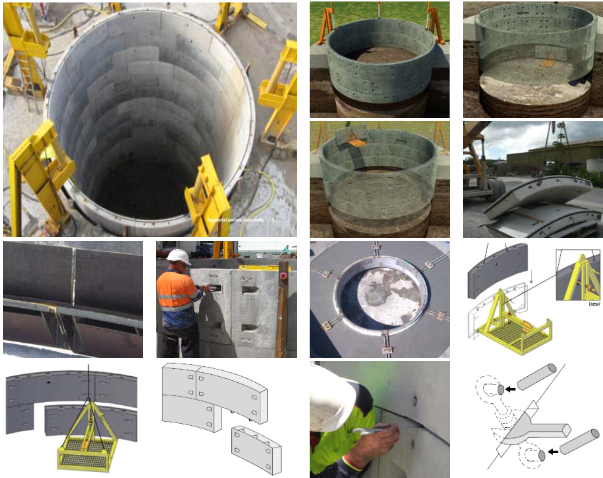
<그림 6.3.2> 수직구 굴착 전경(호주 업체 사례)
