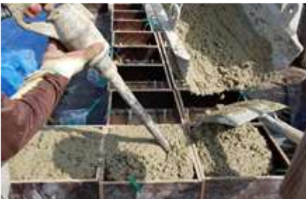
다. 콘크리트 타설 - 진동기 사용
