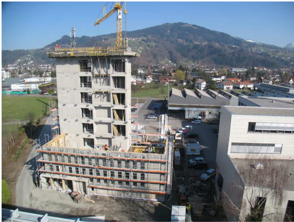
[그림 6-3] LCT One 횡력저항시스템 - RC 코어 벽
