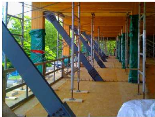
[그림 6-6] The Earth Sciences Building at UBC의 횡력저항시스템 - 역V형 가새골조와 트러스
