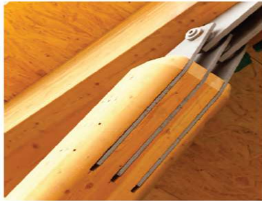
[그림 6-6] The Earth Sciences Building at UBC의 횡력저항시스템 - 역V형 가새골조와 트러스
