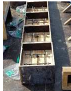
나. 콘크리트 타설 전 철근 배근 상태
