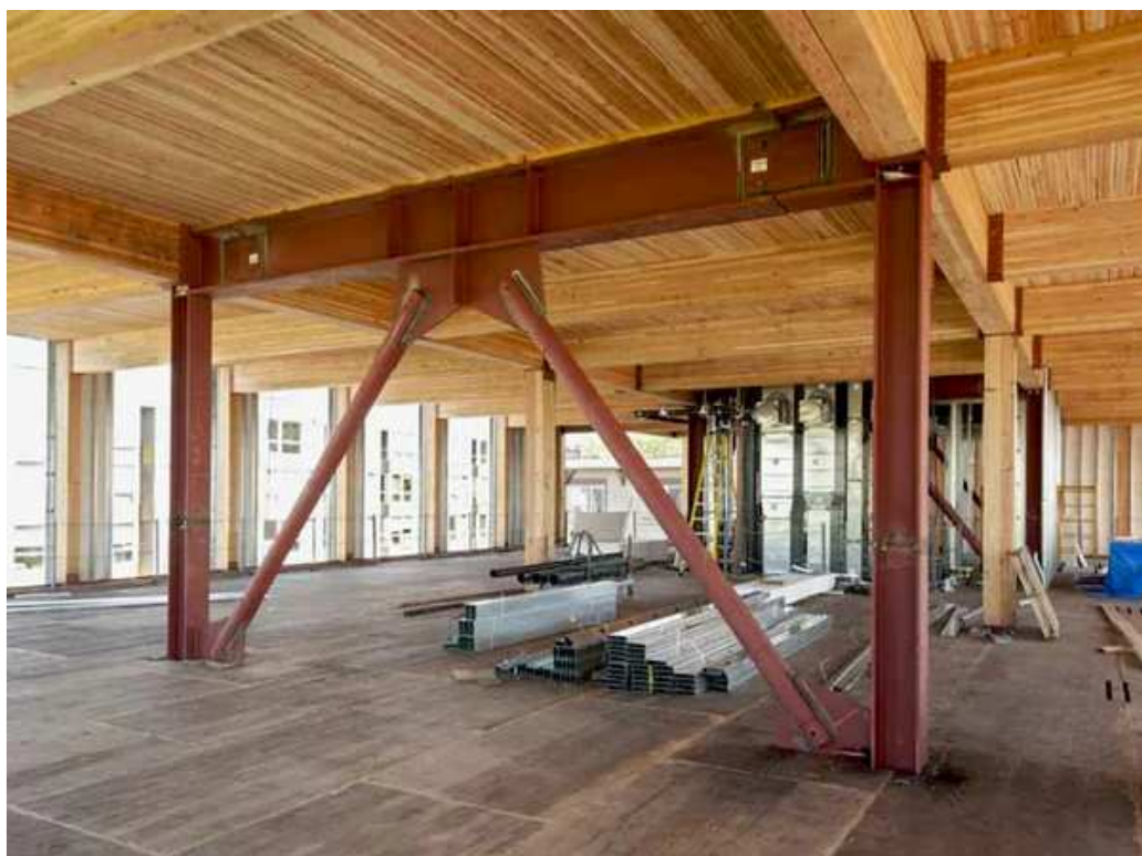
[그림 6-13] Bullitt Center의 횡력저항시스템 - 철골 가새 골조
