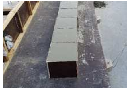
라. 콘크리트 양생
