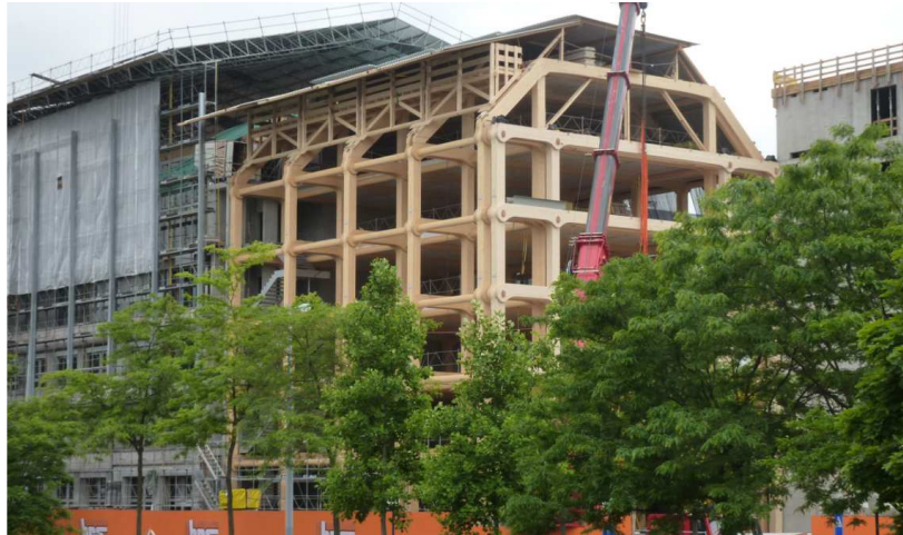
[그림 6-11] Tamedia office building의 횡력저항시스템 - 목재 가새
