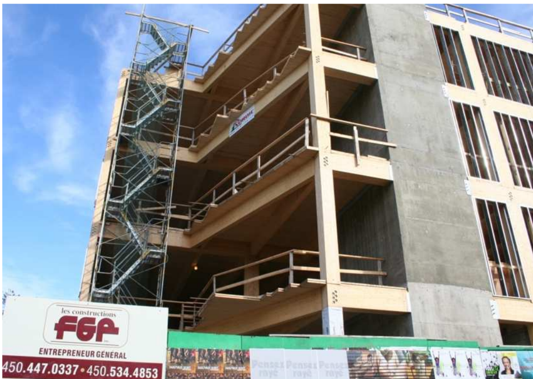
[그림 6-8] Fondaction CSN Building의 횡력저항시스템 - RC 코어 벽
