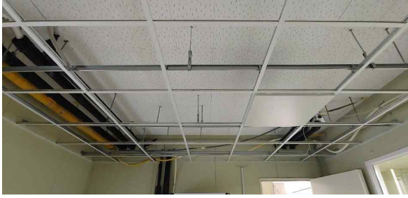
(a) 플레넘 형성 및 T-bar 설치
