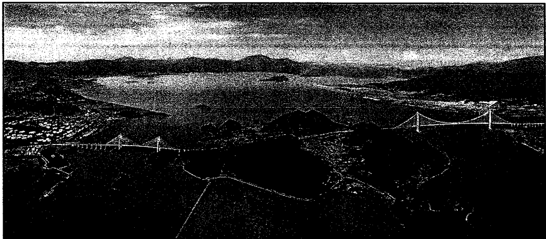
그림 1.1.3 여수산단 진입도로 건설 (사장교 760m, 현수교 1,760m)
